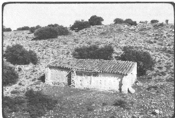
Fig. 5.-Colmenar con muro, protegido también por el sur; tipo zona baja, protegido con teja árabe. De las proximidades de Navajo Blanco (Used, provincia de Zaragoza).
