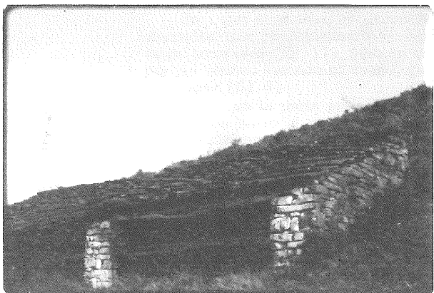
Fig. 3.-Colmenar aragonés de montaña, con tejado de losas (Ascara, provincia de Huesca).
