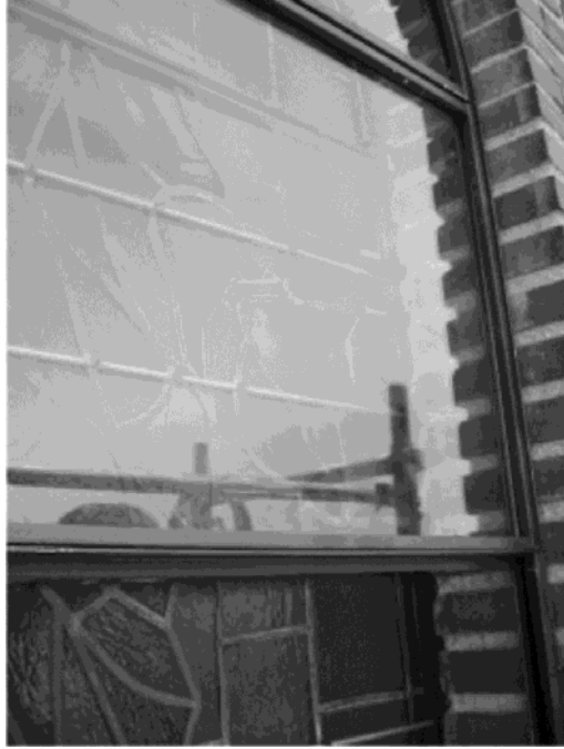
Figura 17. Imagen de una vidriera restaurada y reinstalada, con el cerco metálico exterior preparado para el acristalamiento protector.
