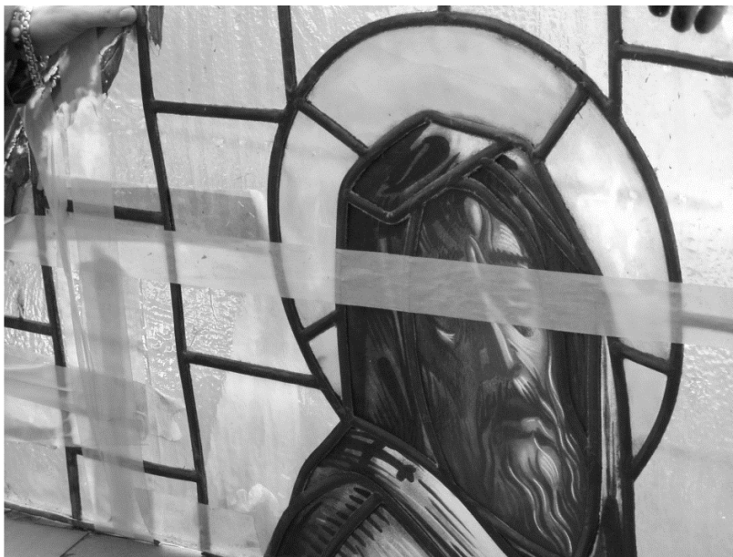
Figura 13. Imagen de un panel de vidriera encintado para su transporte.
