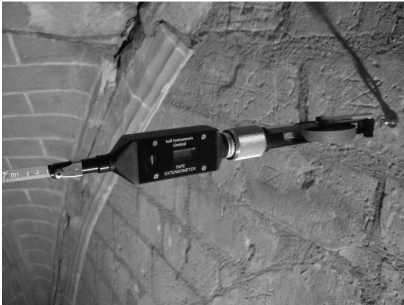
Figura 8. Medición de deformaciones mediante cinta extensométrica. Instrumentación realizada por Tecnum .
