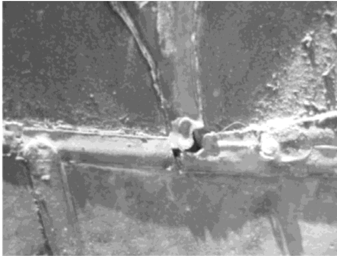
Figura 15. Imagen de un panel de vidriera con rotura en la soldadura del emplomado.
