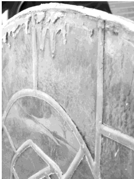
Figura 8. Imagen de una vidriera con restos de masilla aplicada en estado muy fluido.
