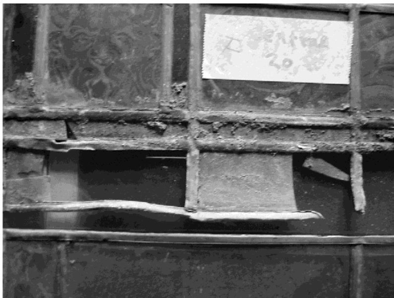
Figura 5. Imagen de un fragmento de vidrio con daños mecánicos y capa de suciedad.
