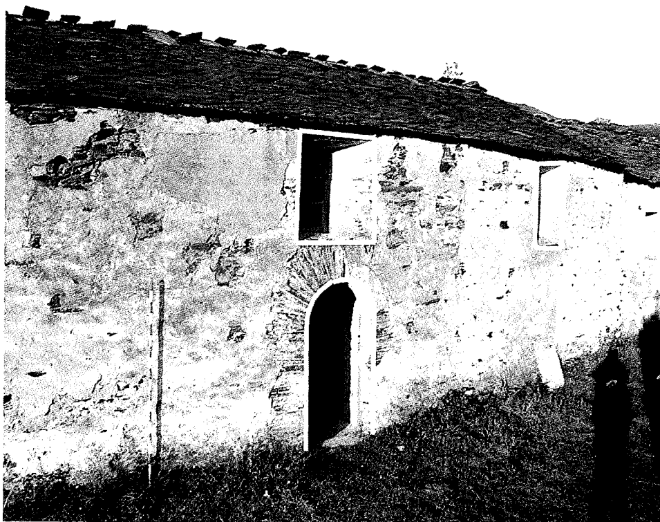
Figura 15. Detalle del alzado S del edificio, viéndose el tipo de ventanas y la puerta S, abiertas en la Fase Moderna III a finales del S. XVIII, principios del S. XIX.
