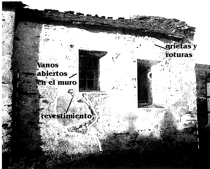
Figura 16. Alzado S del ábside. En la fotografía se diferencian las ventanas abiertas en la fase anterior y las roturas y reparaciones provocadas por éstas, llevadas a cabo en esta fase.
