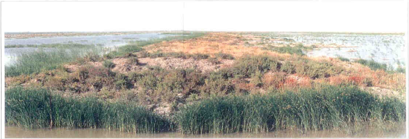
Caño Guadamar en su tramo sur. Puede observarse el encauzamiento (izda), el levée artificial (centro) y resto del antiguo cauce (derecha). En primer plano se aprecia uno de los canales que drenan las márgenes originales llevando el agua hacia el encauzamiento (V/96)
