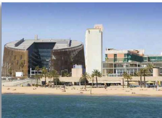
Current seat of the new Instituto de Biología (CSIC-UPF) in Barcelona: the Centro Mediterráneo de Investigaciones Marinas y Ambientales (CMIMA), on the right, and the Parc de Recerca Biomèdica de Barcelona (PRBB), on the left.
