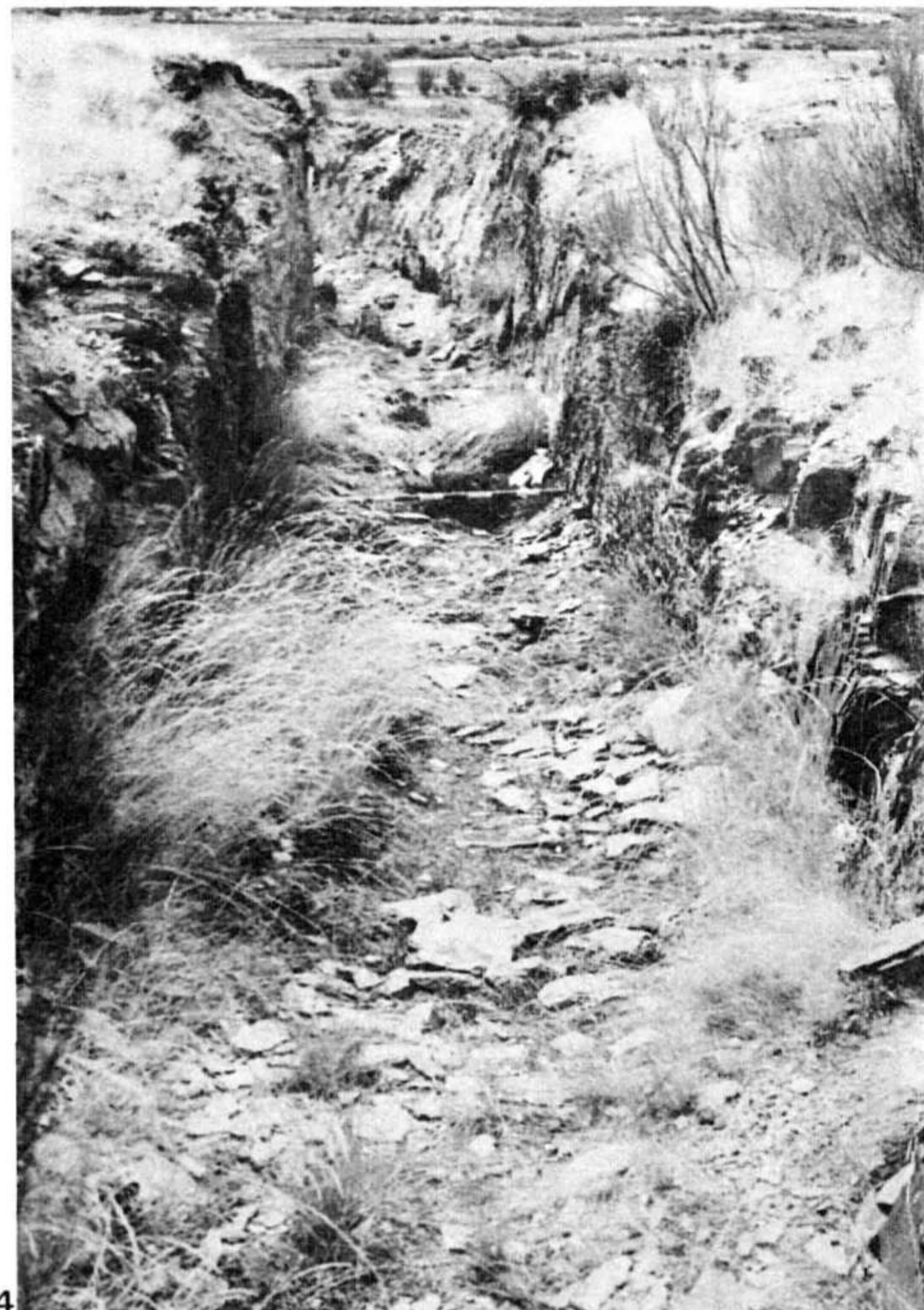
Lám. II.—3. Obra de fábrica y roca cortada, «rupes inviae caeduntur» (Plin. NH, 33, 74), para dar paso a los canales de aportación de agua que se dirigían a Las Médulas de Carucedo, C-7, por los Montes Aquilianos. 4. Cauce labrado en la roca de un canal captado por debaio de la Corona de Corporales a su paso por el Alto de Peña Aguda.
