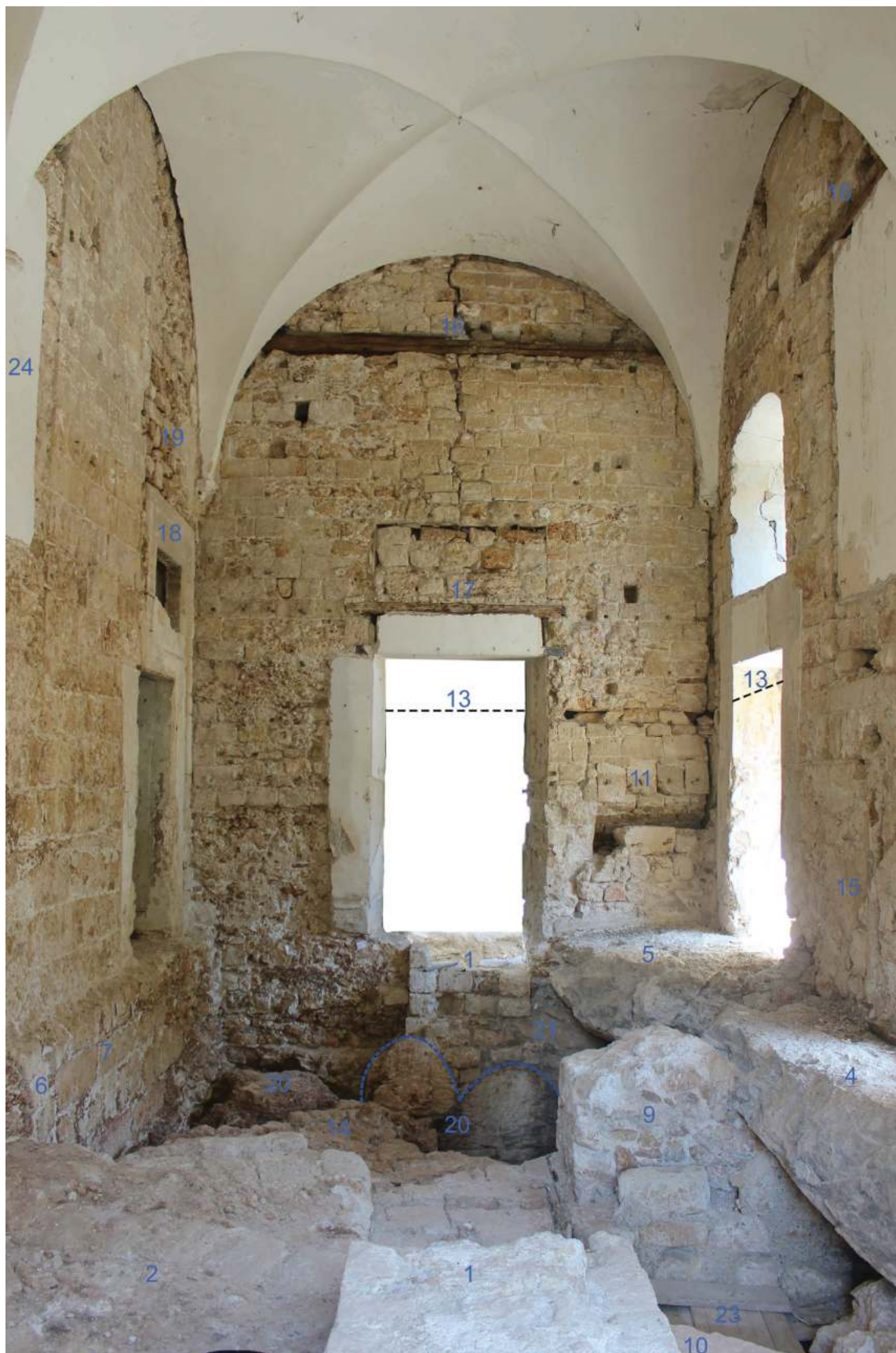
Fig. 10. Palermo, Cuba Soprana. Espacio 6. Vista desde el sur. A la izquierda se aprecia la plataforma inclinada (2) que protege los tubos metálicos que alimentaban la alberca (10). Al fondo se ve un muro seccionado (1) perteneciente a la fachada fundacional, cimentado directamente sobre la roca (20). A la derecha están dos (4 y 5) de las tres grandes rocas que hay en el interior del estanque (10). Debido a problemas de estabilidad de fachada fundacional (1) fue necesario reforzarla con una obra de mampostería y cal (9). En la fase II el edificio se amplió sobre la alberca (10) y para ello fue necesario construir una nueva fachada (15) y cubrir las grandes rocas con tres bóvedas (11). El nº 13 señala la cota a la que estaba el suelo de la plataforma sobre la que se alzaba el pabellón (foto LAAC, EEA, CSIC).
