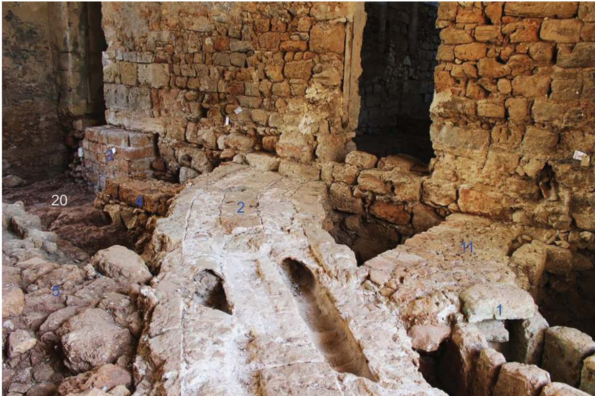
Fig. 17. Palermo, Cuba Soprana. Espacio 9. Vista desde el suroeste. Sobre la base rocosa (20) se cimentaron todas las estructuras medievales. El nº1 es una infraestructura hidráulica que fue inutilizada por un muro normando (11), mientras que el 2 es la conducción que estuvo en activo, al menos, durante los siglos X-XII. El cimiento de sillería señalado con el nº 3 corresponde al hipotético límite occidental del pabellón fundacional, mientras que el 5 pertenecería a la plataforma de ese mismo momento (foto LAAC, EEA, CSIC).
