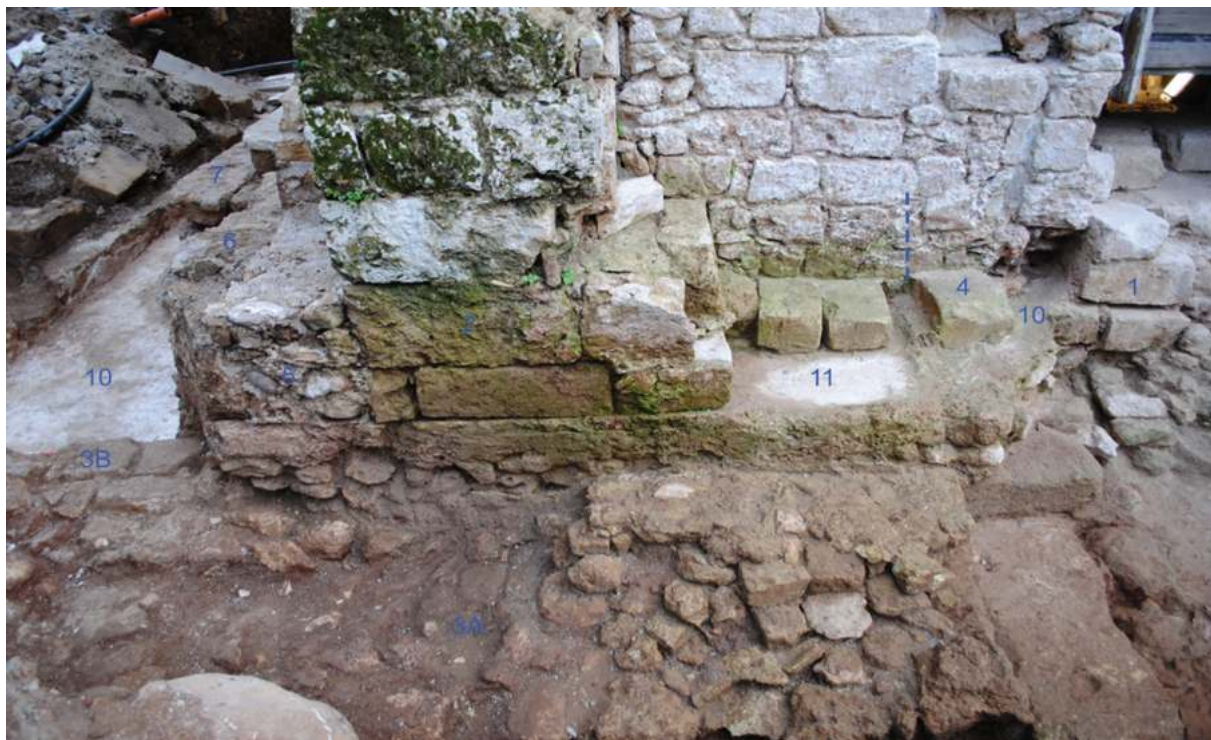
Fig. 24. Palermo, Cuba Soprana. Vista desde el norte. El nº1 es la base de la fachada fundacional (fase I). El 2 es la cimentación de la fachada oriental (fase II). El 5 es el muro de refuerzo que se le hizo a la fachada en el siglo XVI. El 6 corresponde a la escalera barroca. En relación con el estanque, el 3A señala su muro perimetral de mampostería tomada con mortero de tierra y el 3B el forro de sillería; el 10 es el pavimento más antiguo y el 11 el más reciente (foto LAAC, EEA, CSIC).
