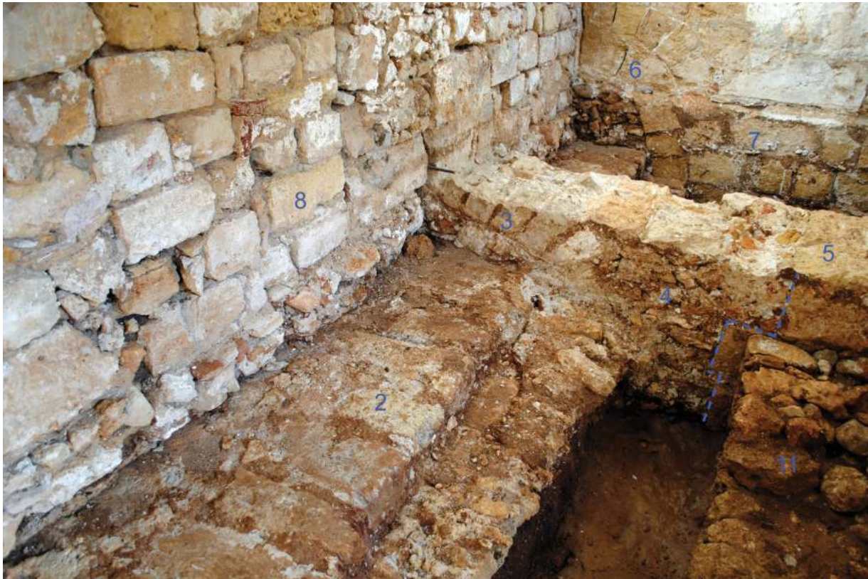
Fig. 29. Palermo, Cuba Soprana. Espacio 8. Vista desde el oeste. Los dos muros normandos (4 y 7) contaron con arcos de descarga (3 y 6) con el fin de proteger a la conducción hidráulica (2). Sobre esta última se cimenta un muro (8) perteneciente a la reforma del siglo XVI. El nº 5 es el cimiento de uno de los pilares del pórtico normando (foto LAAC, EEA, CSIC).
