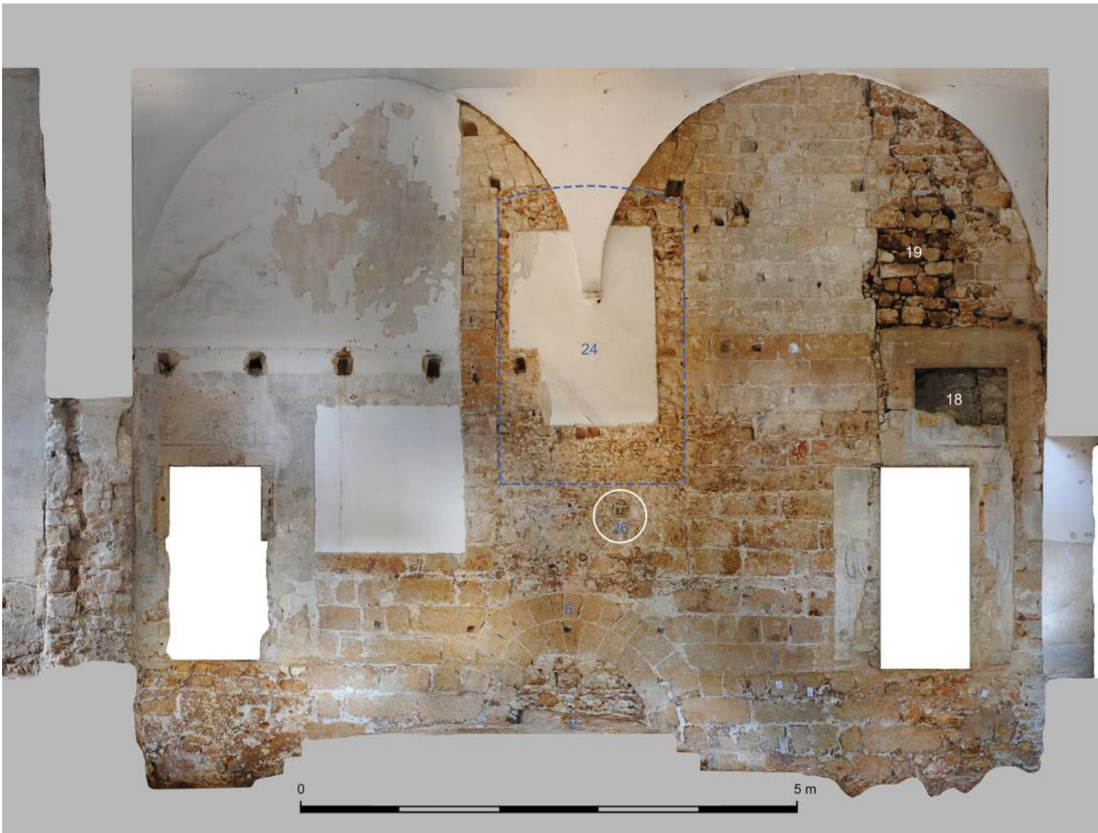
Fig. 32. Palermo, Cuba Soprana. Espacio 6. Ortofoto del alzado del muro normando (7) visto desde el este. El 24 es la puerta de acceso al salón de la planta baja. El 18 es un vano perteneciente a la fase bajomedieval en la que el edificio fue usado, probablemente, como palomar. El 19 es una obra de mampostería bajomedieval cerrando un vano normando. El 6 es el arco de descarga construido sobre la infraestructura hidráulica (2). El 26 es una caja de madera que probablemente se hizo para proteger el tubo metálico por el que llegaba el agua a las dependencias del frente oriental del pabellón, (LAAC, EEA, CSIC).
