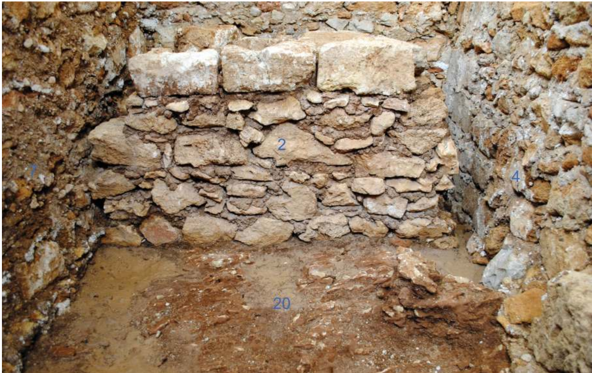
Fig. 15. Palermo, Cuba Soprana. Espacio 8. Vista desde el norte. Sobre la base rocosa (20), un fragmento de muro de mampostería (2) trabada con mortero terroso de color rojizo, perteneciente al edificio fundacional, aparece cortado por dos muros normandos (4 y 7) en los que es abundante el mortero de cal (foto LAAC, EEA, CSIC).
