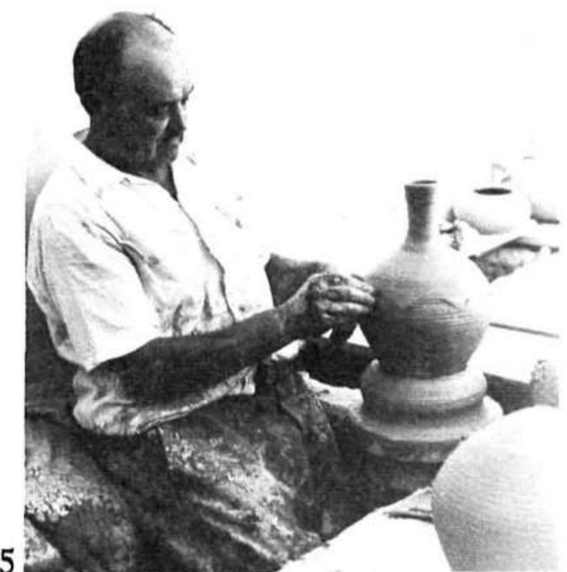
Lámina V: Acabado de un cántaro, Huescar (1-4. Embocando sobre una horma de barro; 5. Decorando en el torno con peine; 6. Abriendo los orificios de la rejilla ).
