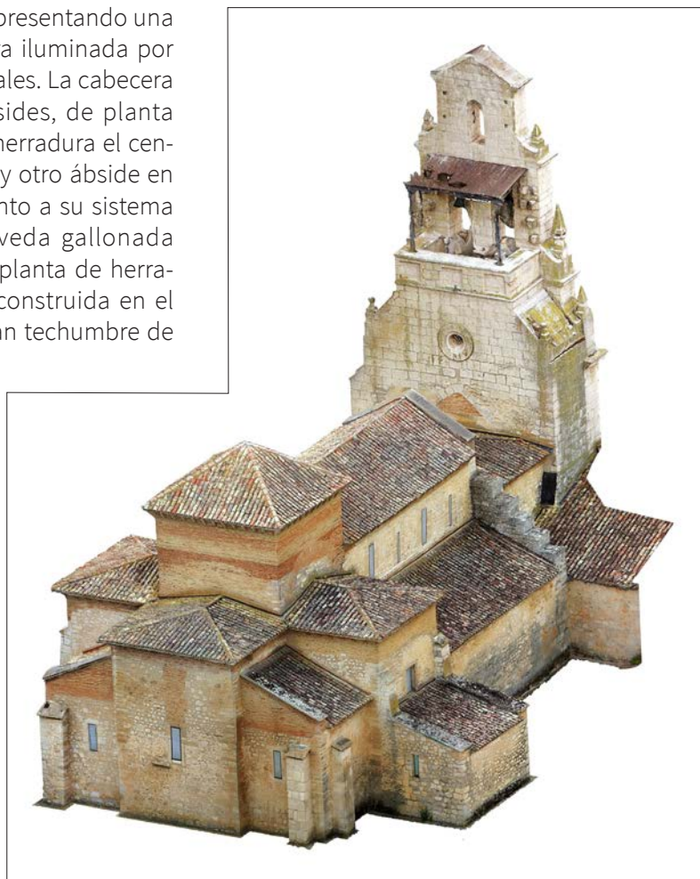
Fig. 9. Iglesia de San Cebrián de Mazote (Valladolid). Fotogrametría y modelo 3D, UrbeproOrbe
