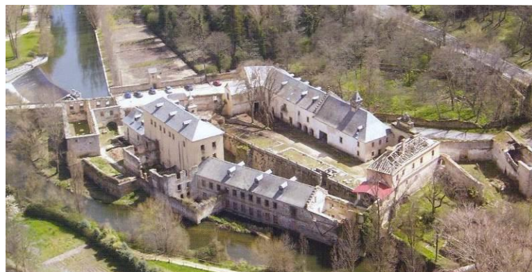
Figura 46. Fotografía aérea oblicua del complejo del Real Ingenio de Moneda de Segovia antes del inicio de las obras de rehabilitación, donde se aprecia su proximidad y relación con el río Eresma. Tomada de Murray (2006).
