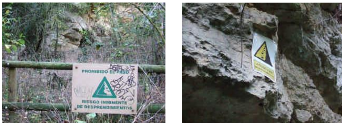
Figura 110. Señalización del peligro de desprendimientos en los vallados de la zona peatonal (izquierda) y en los taludes más inestables de las áreas estanciales (derecha).
