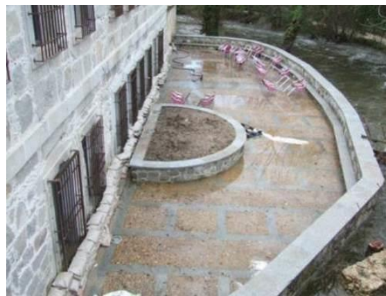
Figura 65. Vista de la terraza del bar-restaurante Ingenio Chico tras el bombeo del agua acumulada tras el muro perimetral y con los sacos terreros en puertas y ventanas para tratar de prevenir otras posibles inundaciones.
