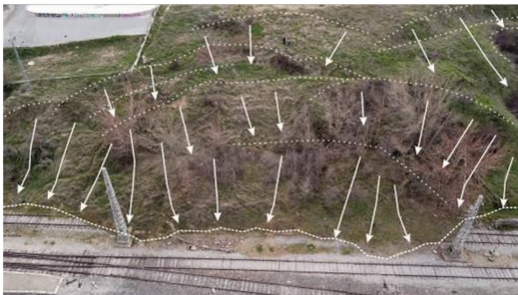
Figura 118. Fotografía aérea oblicua de la lengua y el pie del deslizamiento de la estación de ferrocarril convencional de Segovia, invadiendo las vías de reserva y desplazando y rompiendo el murete perimetral; con sus líneas de rotura bloques hundidos y levantados y direcciones preferentes de flujo. Foto: Rodrigo Verdugo Vicente.
