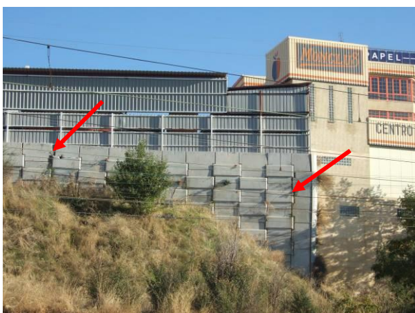
Figura 123. Agrietamientos y desencajamientos de los muros y módulos de la cimentación de edificios y naves en las inmediaciones del deslizamiento.
