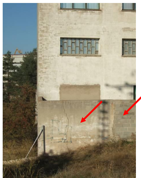
Figura 123. Agrietamientos y desencajamientos de los muros y módulos de la cimentación de edificios y naves en las inmediaciones del deslizamiento.
