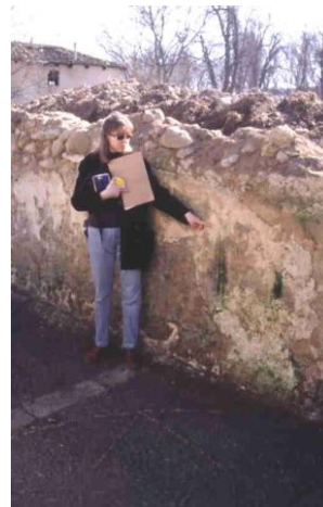
Figura 39. Restos del antiguo claustro y arranque de los muros del monasterio, que permiten reconstruir con precisión los niveles de inundación descritos.
