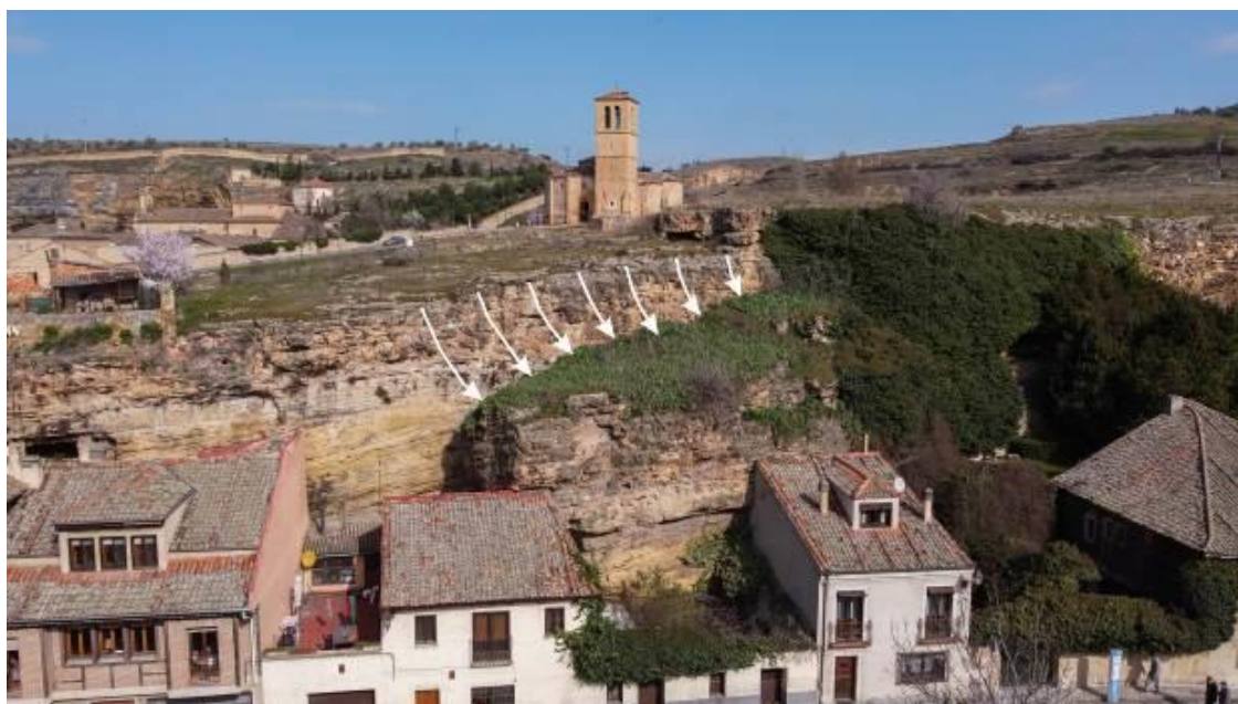
Figura 82. Bloque deslizado de rocas de San Marcos, con las casas adosadas. Foto: Rodrigo Verdugo Vicente.
