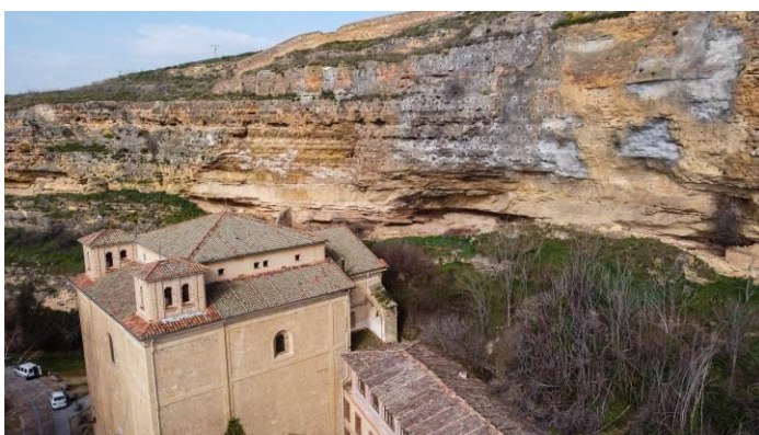
Figura 97. Vista aérea de la zona de Peñas Grajeras, donde se observa perfectamente la zona del desprendimiento del 7 de abril de 2005, ahora gunitada y bulonada. Foto: Rodrigo Verdugo Vicente.
