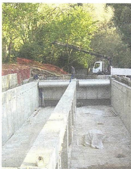
Obras de ejecución del tanque.
