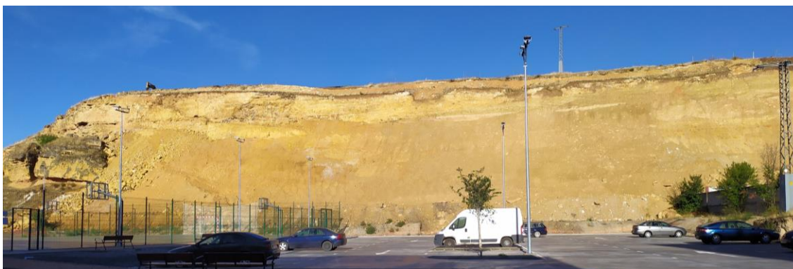
Figura 126. Aspecto del talud de la trasera del colegio Carlos de Lecea en septiembre de 2021, una vez se construyeron un aparcamiento de vehículos y pistas polideportivas al pie, y se iniciaron obras de retranqueado del talud y terraplenado del pie.
