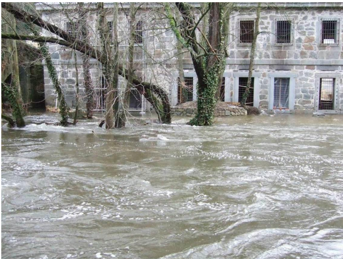
Figura 58. El río Eresma desbordado a la altura de la Casa de Moneda, inundando el edificio del Ingenio Chico en la margen izquierda. 29 de enero de 2009.
