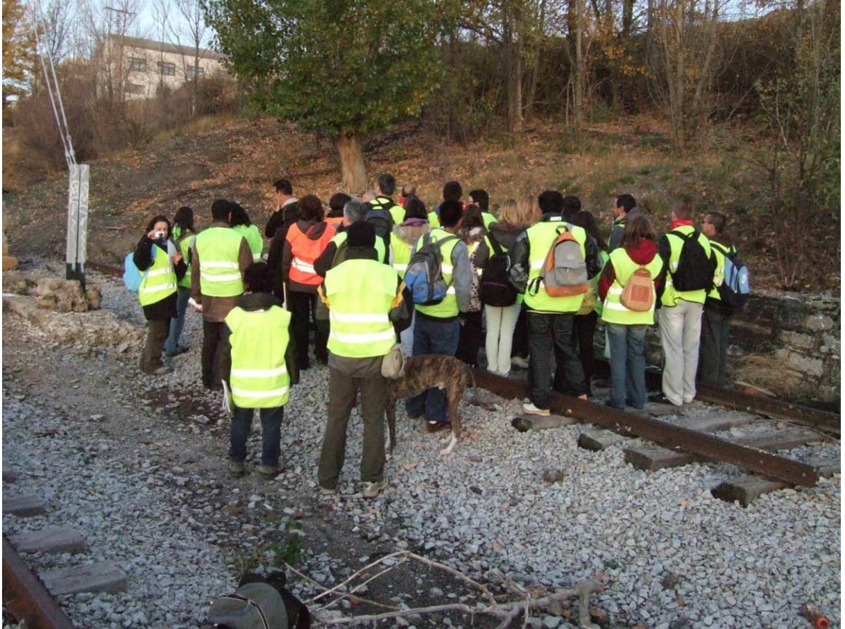
Figura 22. Visita al deslizamiento rotacional de la estación de ferrocarril de Segovia, que cubrió e inutilizó las vías férreas, por uno de los cuatro subgrupos de asistentes a la excursión A todo riesgo IV (año 2010).
