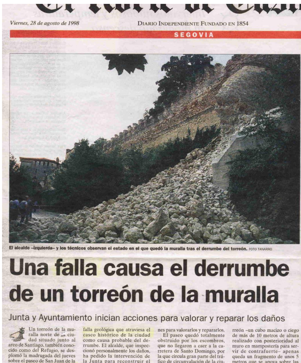
Figura 81. Recorte de la noticia en la edición impresa de El Norte de Castilla al día siguiente del desprendimiento, donde se puede leer la atribución del suceso a "...una falla geológica que atraviesa el casco histórico de la ciudad..."
