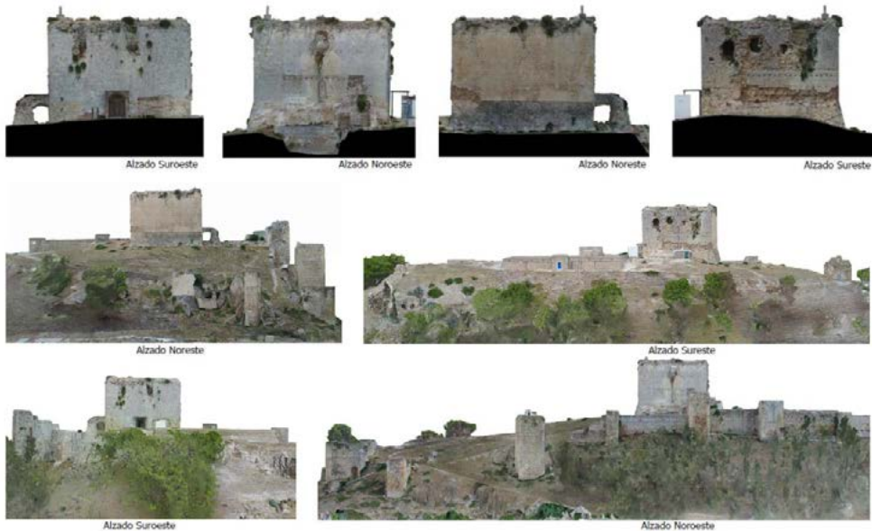
Figura 4. Ortofotografías obtenidas por procedimientos fotogramétricos de los alzados exteriores de la Torre Gorda y del recinto del Castillo de Morón de la Frontera (20 de septiembre de 2019). Autor: Luis García Pulido
