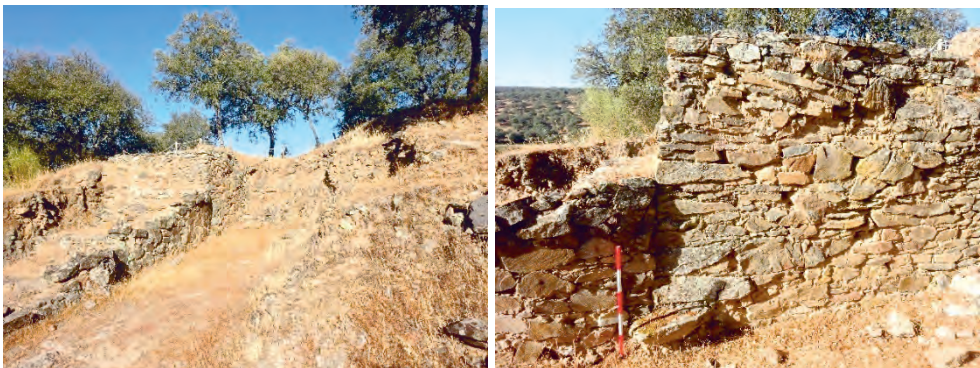
Fig. 104 a) Fortaleza de entrada b) Detalle del paramento de la fortaleza de entrada
