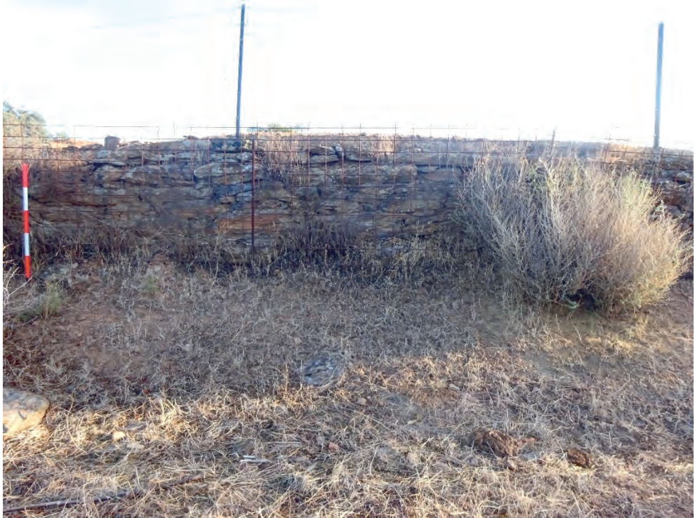
Fig. 191 Paramento de piedra de la estructura interior
