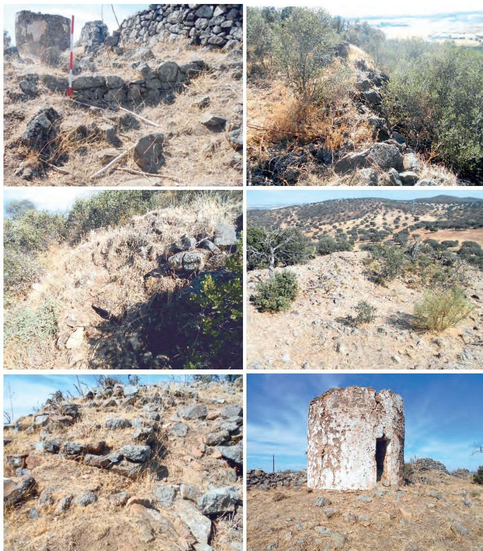
Fig. 47 Sierra del Castillo: a - d) Paramento recinto interior e) Detalle estructura avanzada del recinto interior f) Atalaya medieval
