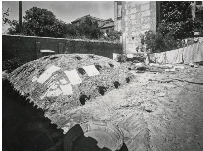
Figura 2. Extradós de las bóvedas del Bañuelo antes de la obra de intervención de Torres Balbás (APAG F-003262).
