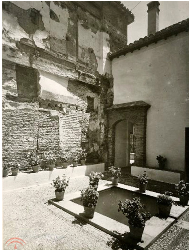
Figura 7. Medianería sin tratar en la vivienda del patio de acceso, una vez finalizadas las obras en 1927-28 (APAG F-007284).
