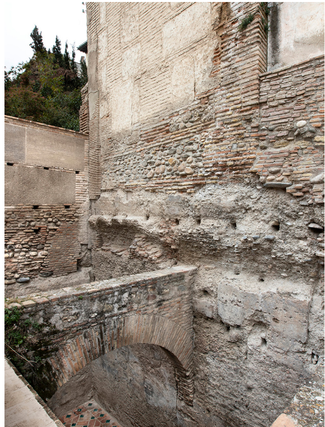
Figura 12: Vista superior de sala de servicio. Foto: C. García Zarza.
