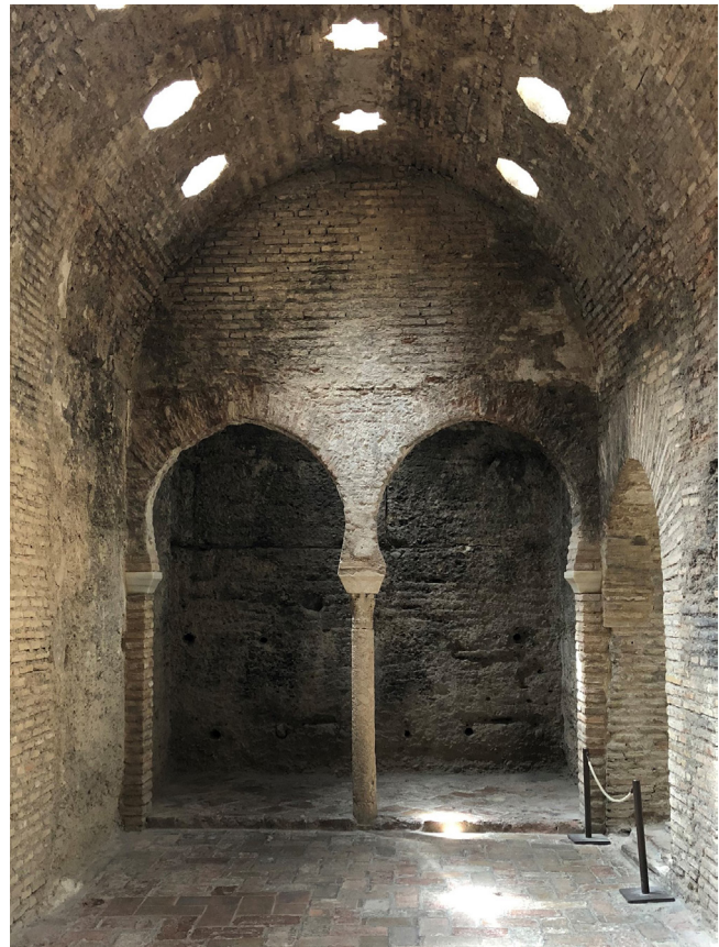
Figura 10. Alhanía oeste de la sala caliente del Bañuelo, con las actuales pilastras de ladrillo y cimacios.
