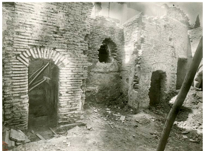
Figura 4. Patio de acceso al Bañuelo durante la ejecución de las obras de Torres Balbás en 1927-28 (APAG F-007288).
