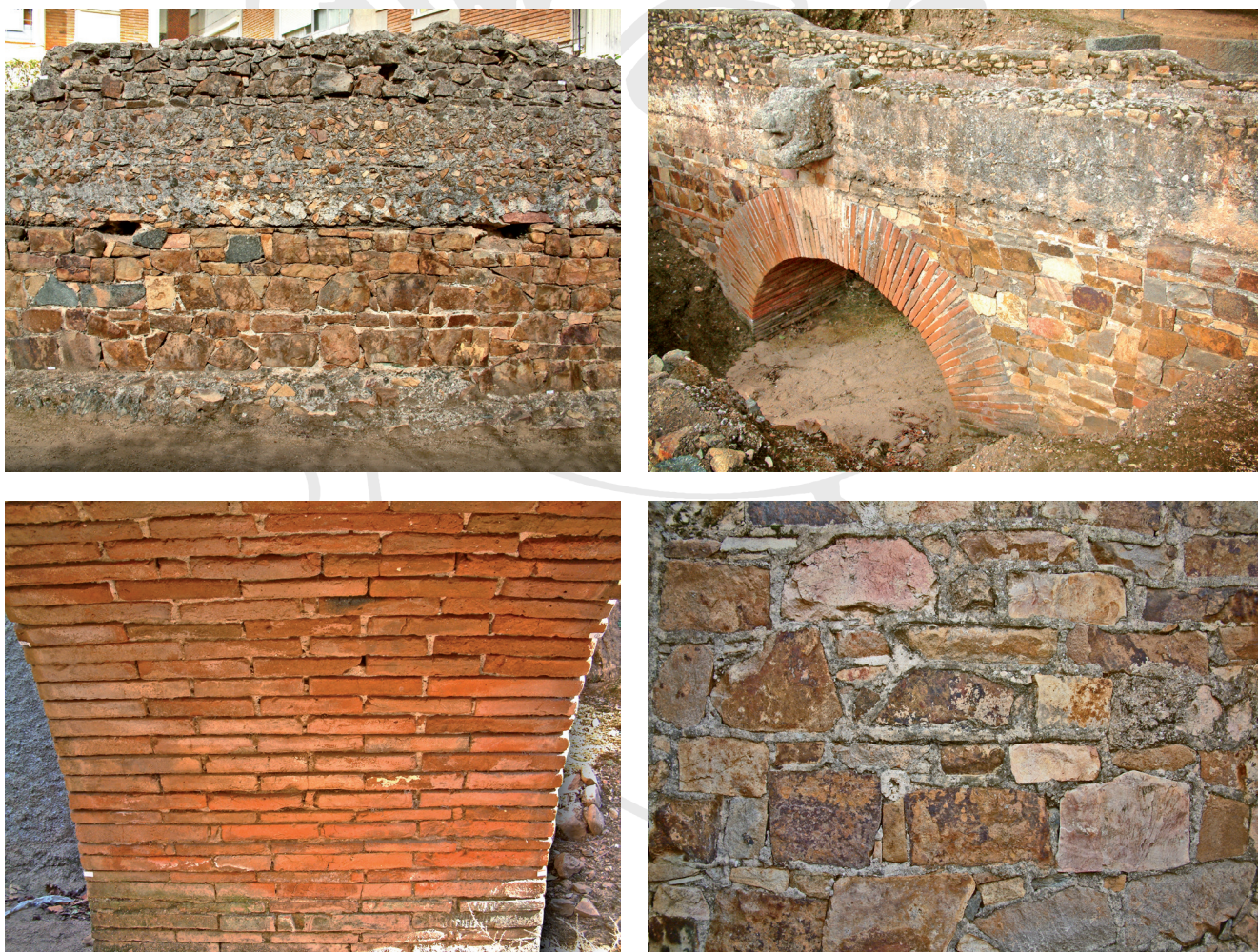
Fig. 16. a-d. Conducción de San Lázaro en la zona de la Casa del Anfiteatro con detalle de la técnica edilicia y mechinales (a); arco de ladrillo y bóveda (b-c); detalle del encintado entre las juntas de los mampuestos (d) (cl. A. Pizzo).
