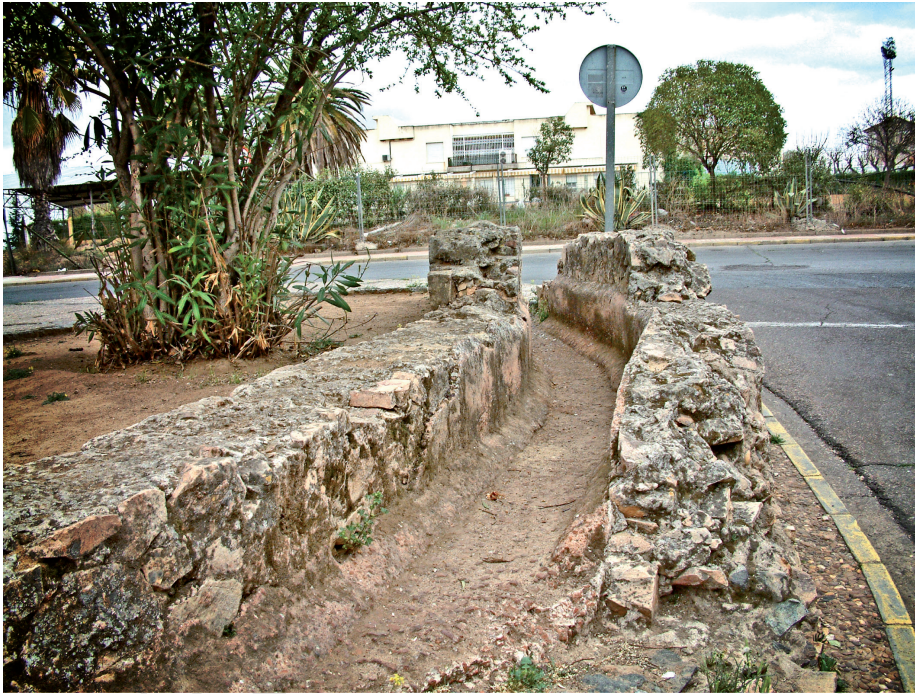
Fig. 21. a-b . Tramo del acueducto de Cornalvo en la vía de Ensanche ( a ) y detalle del encintado de las juntas entre los mampuestos ( b ) (cl. A. Pizzo).
