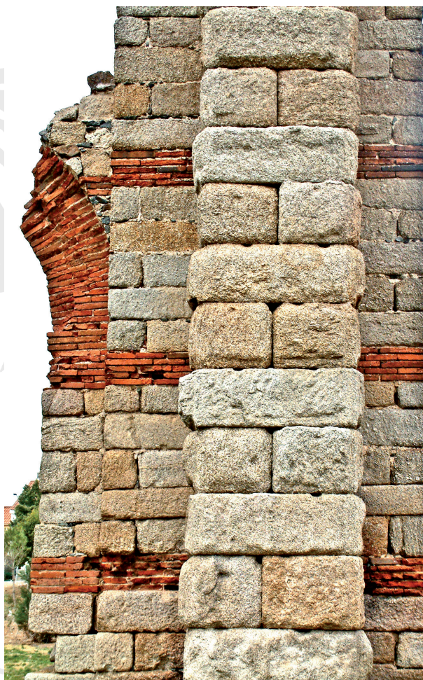
Fig. 9. Detalle del arranque de un arco de ladrillo original (cl. A. Pizzo).
