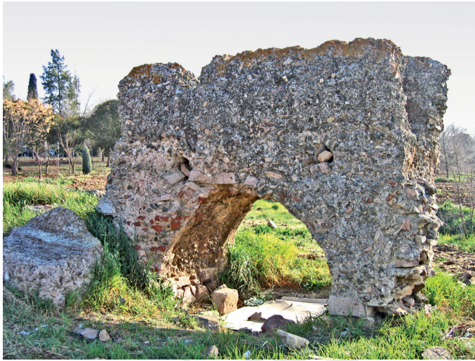
Fig. 20. a-b . Tramo del acueducto de Cornalvo en hospital psiquiátrico de Mérida. Detalle del arco conservado ( a ) y la canalización ( b ) (cl. A. Pizzo).
