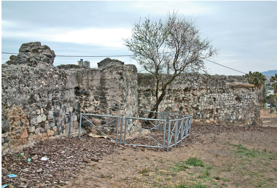
Fig. 11. Vista general de la canalización del acueducto de los Milagros y relación con la piscina limaria (cl. A. Pizzo).
