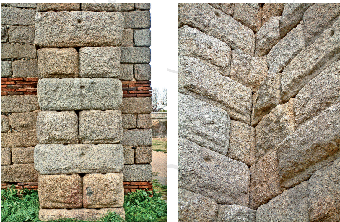
Fig. 7. a-b . Detalle de los orificios de las palancas empleadas en la colocación y alineación de los sillares e granito ( a ); detalle del sistema de unión de pilares y contrafuertes ( b ) (cl. A. Pizzo).
