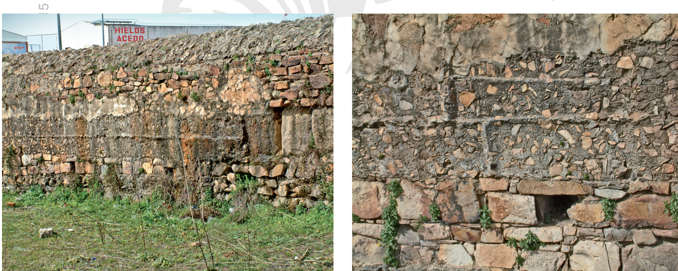
Fig. 14. a-b. Tramo de conducción de San Lázaro sobre elevación (a) y detalle del entablado de madera para la realización del encofrado funcional a la realización del opus caementicium (b) (cl. A. Pizzo).
