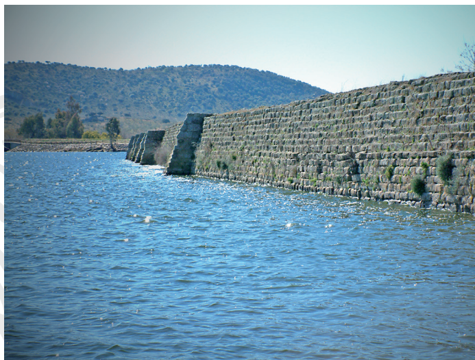
Fig. 2. Vista general de la presa de Proserpina (cl. A. Pizzo).
