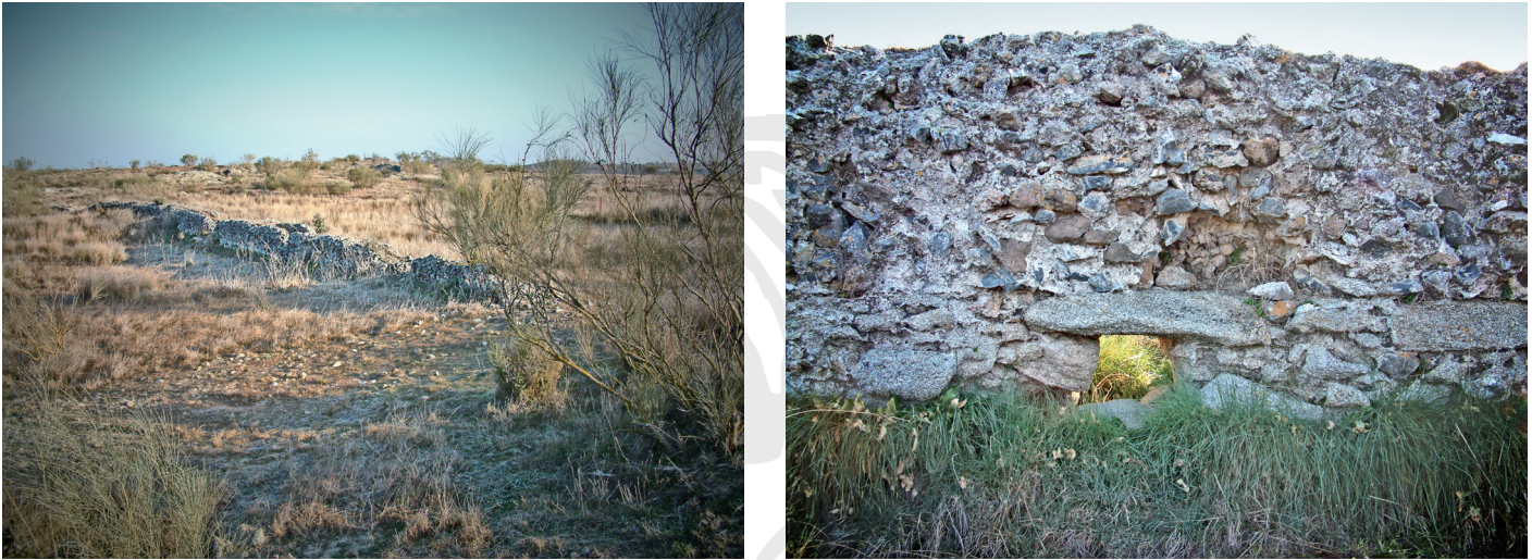
Fig. 5. a-b . Elevación del acueducto de los Milagros en la zona de la Sierra Carija ( a ) y detalle de la técnica constructiva ( b ) (cl. A. Pizzo).
