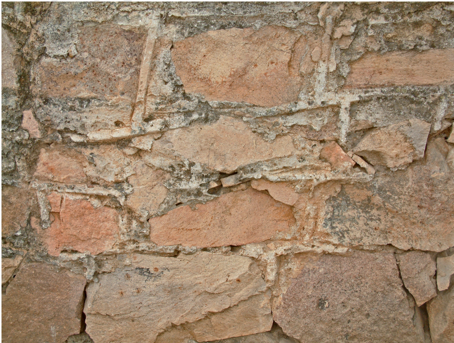
Fig. 21. a-b . Tramo del acueducto de Cornalvo en la vía de Ensanche ( a ) y detalle del encintado de las juntas entre los mampuestos ( b ) (cl. A. Pizzo).
