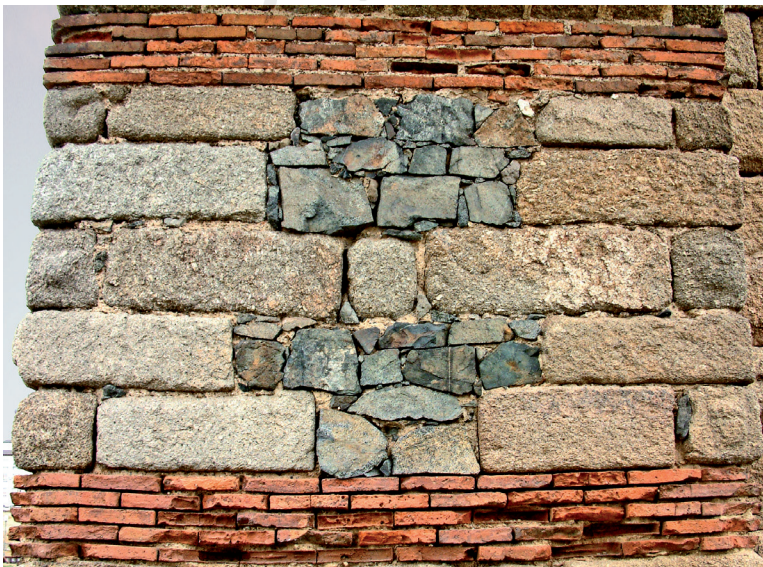
Fig. 8. Almohadillado central en las soluciones de esquinas del interior de los pilares del acueducto de los Milagros y variante en la técnica constructiva (cl. A. Pizzo).
