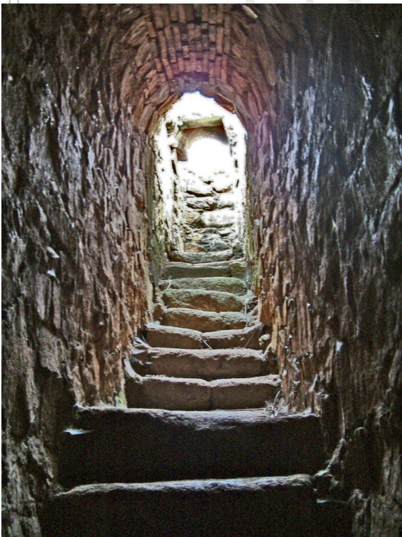
Fig. 13. a-d . Tramo enterrado de la conducción de San Lázaro con pozos de registro-respiradero ( a-b ); detalles de las escaleras de acceso ( c ) y la técnica constructiva de la canalización ( d ) (cl. A. Pizzo).
