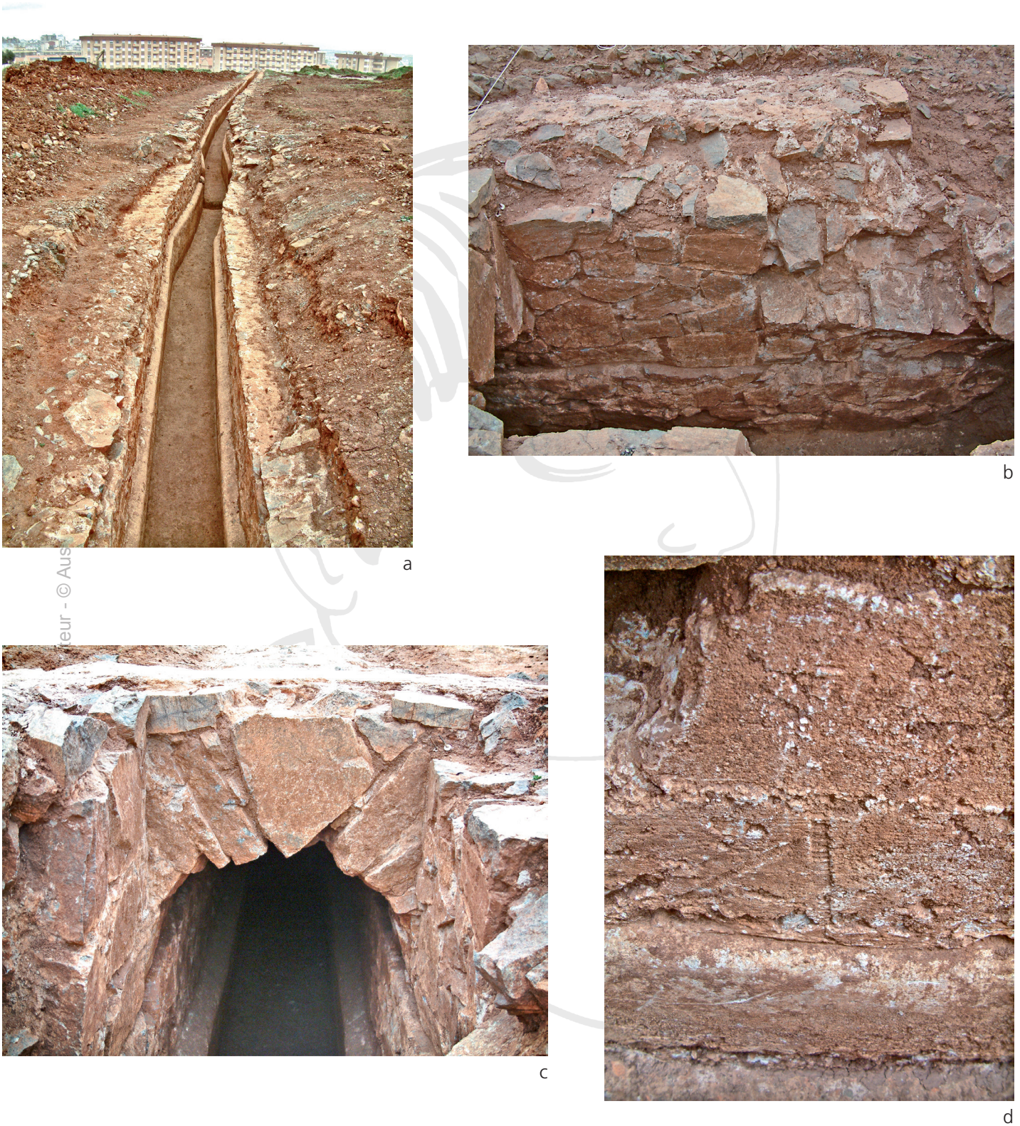
Fig. 3.a-d. Canalización en la zona del Camino del Palo (a) y detalles constructivos: muros de contención y mechinales (b); bóveda (c); improntas de encofrado (d) (cl. A. Pizzo).
