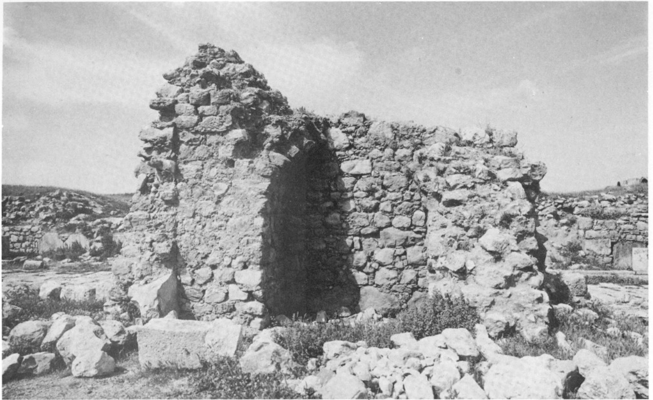
Lám. 52.a.—Restos de la estructura de la escalera de la habitación C I.
