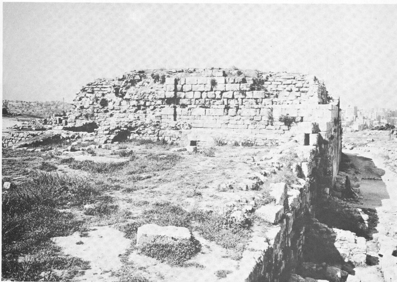
Lám. 13.a.—Vista de la fachada oriental del vestíbulo. لوحة ١٣ أ - منظر للواجهة الشرقية للديوان .
