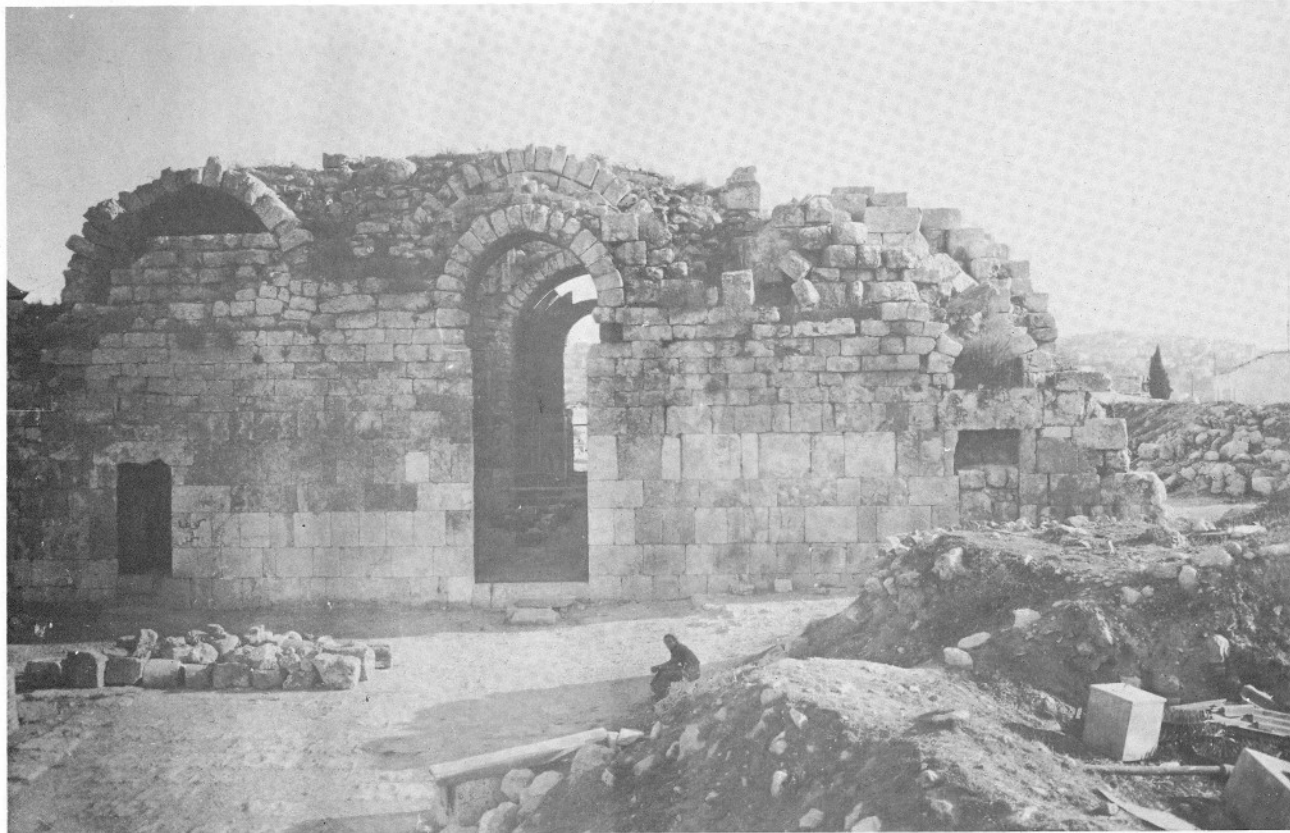
Lám. 24.a.—La fachada norte del vestíbulo. لوحة ٢٤ أ - الواجهة الشمالية للديوان .
