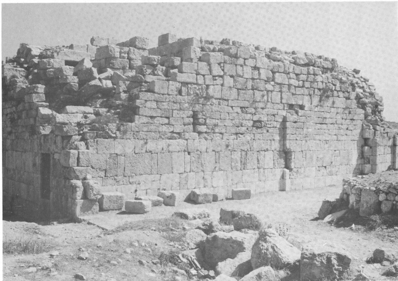
Lám. 16.a.—La fachada occidental del vestíbulo. لوحة ١٦ أ - الواجهة الغربية للديوان .
