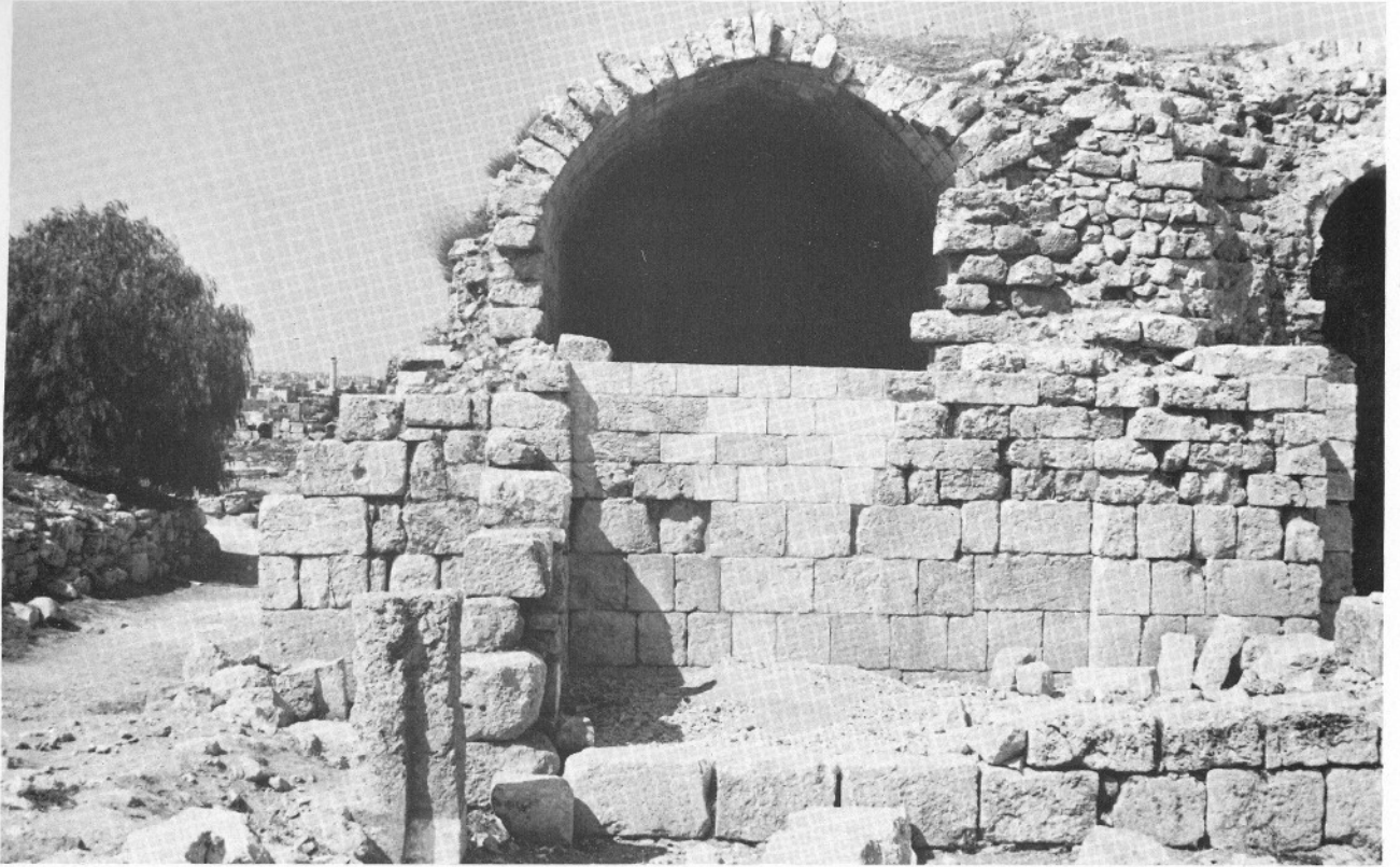
Lám. 12.a.—Parte izquierda de la fachada sur del vestíbulo después de restaurada.
