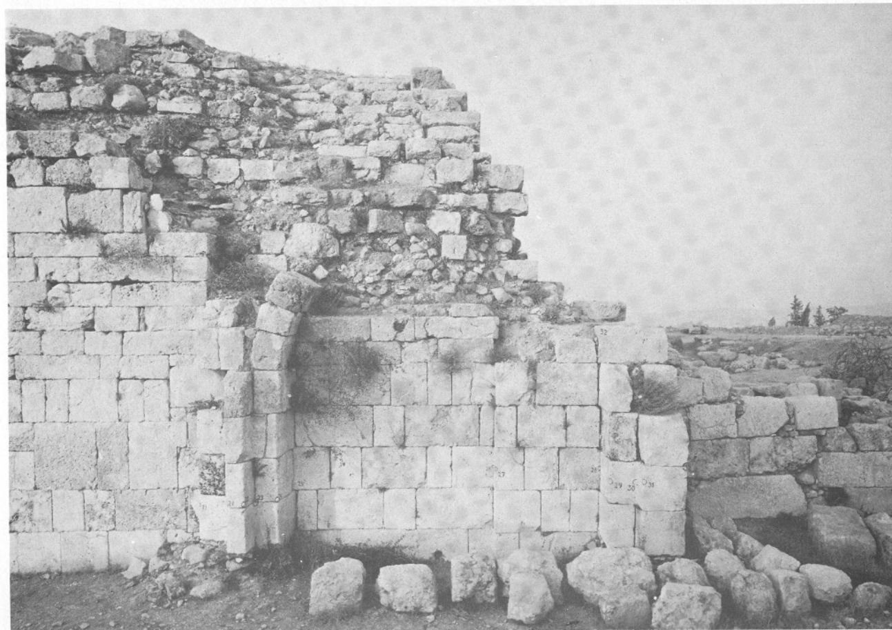
Lám. 16.b.—Detalle de las jambas y arco adosados al muro occidental del vestíbulo correspondientes a la habitación O 1. لوحة ١٦ ب - تفصيل قائمتي الباب ، والقوس المتاخم للجدار الغربي للديوان والتابع للغرفة O 1.
