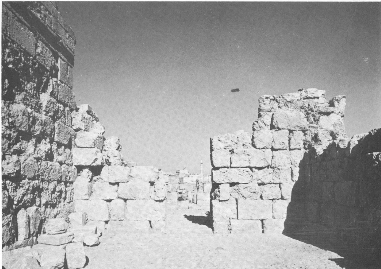
Lám. 58.a.—El muro del fondo del iwān N 1.
