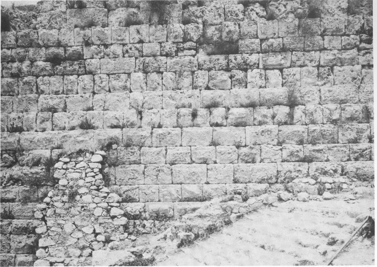
Lám. 7.a.—Detalle de la muralla occidental con restos del talud postizo de época omeya. لوحة ٧ أ - تفاصيل السور الغربي مع باقيا المنحدر المضاف في عصر بني أمية .
