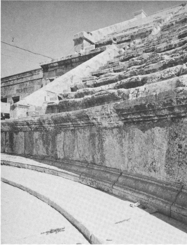
Lám. 45.a.—Detalle del podio que separa la orchestra de la cavea del teatro de Ammán.
