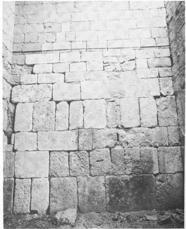
Lám. 25.d.—El mismo muro después de restaurado.
