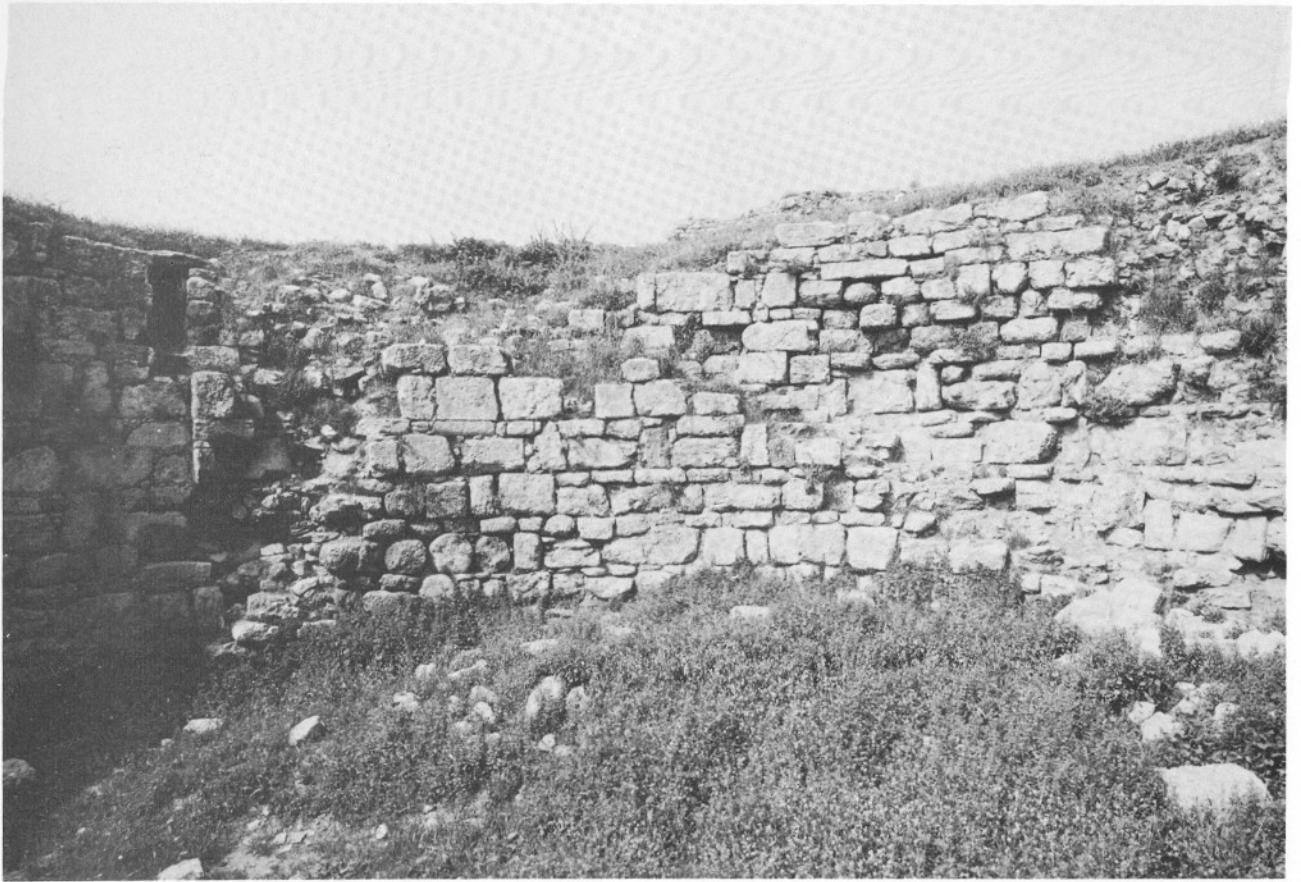
Lám. 36.a.—Interior de la gran alberca con la escalera de bajada y la conducción que vierte junto a ésta.
