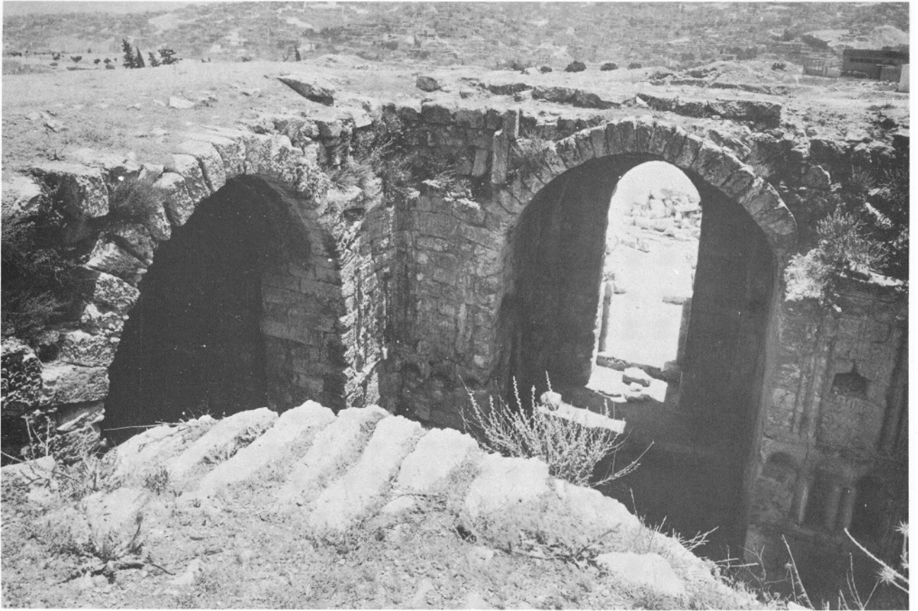
Lám. 28.a.—Vista de la terraza del vestíbulo desde el norte.
