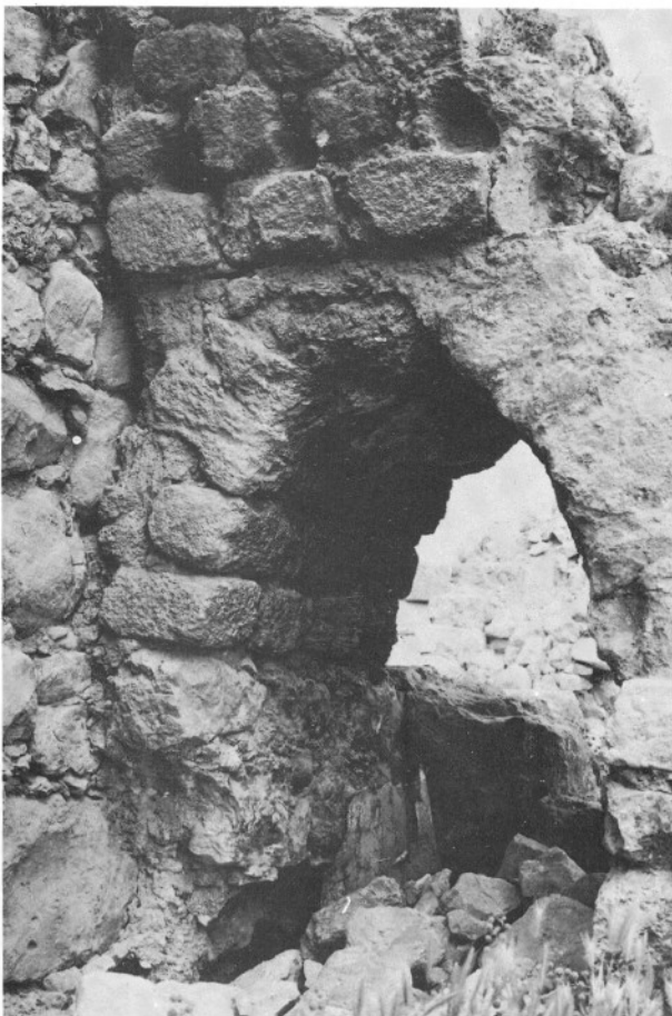
Lám. 52.b.—Detalle del primer arco de soporte de la escalera C I.
