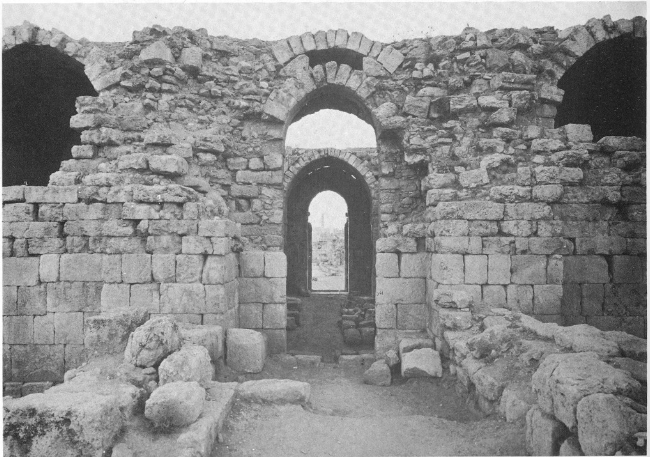
Lám. 11.b.—Detalle de la parte central y puerta de la fachada sur del vestíbulo. لوحة ١١ ب - تفصيل للصالة الوسطية ومدخل الواجهة الجنوبية .
