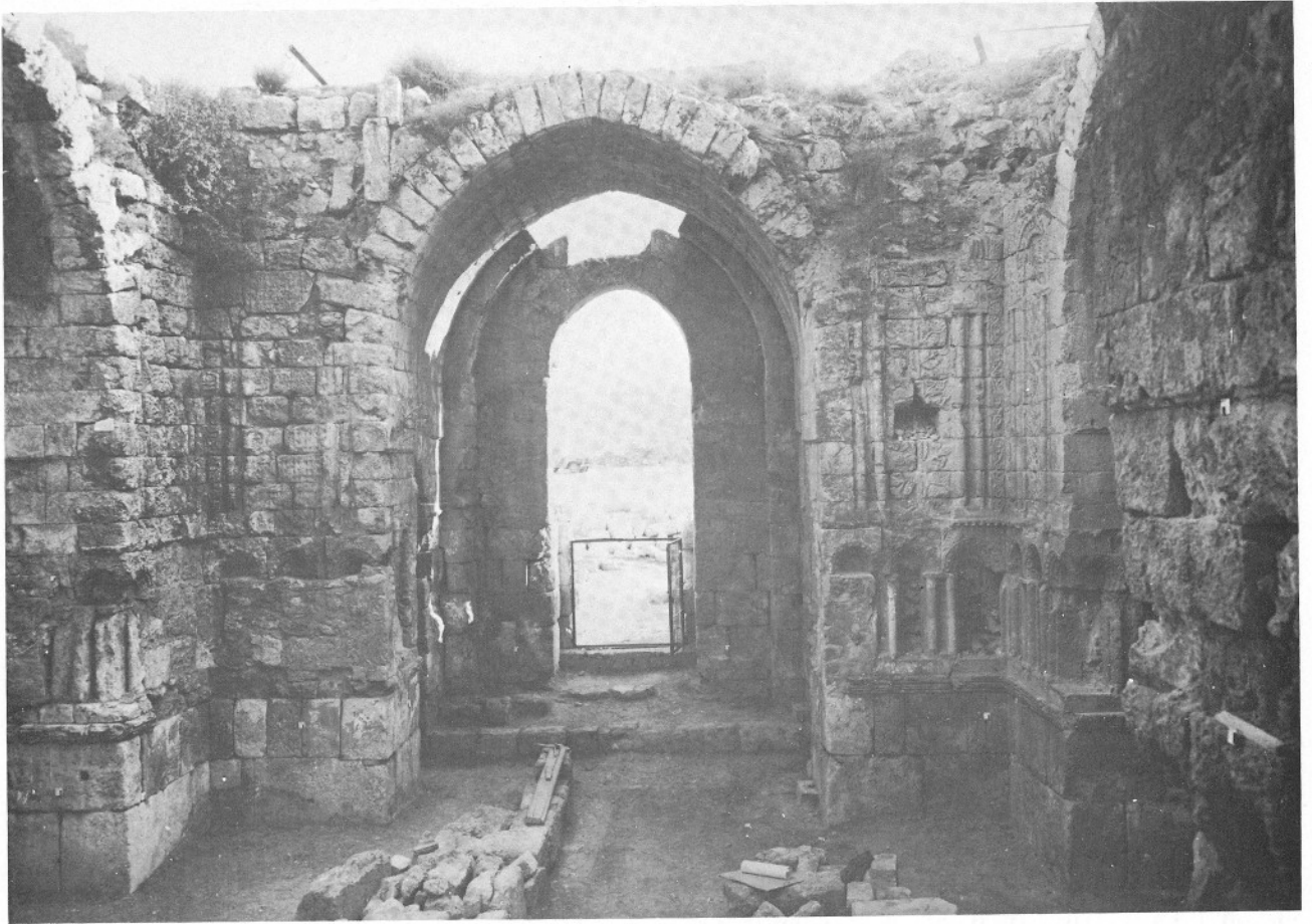
Lám. 18.a.—Vista del interior del vestíbulo hacia el sur, con la puerta meridional.
