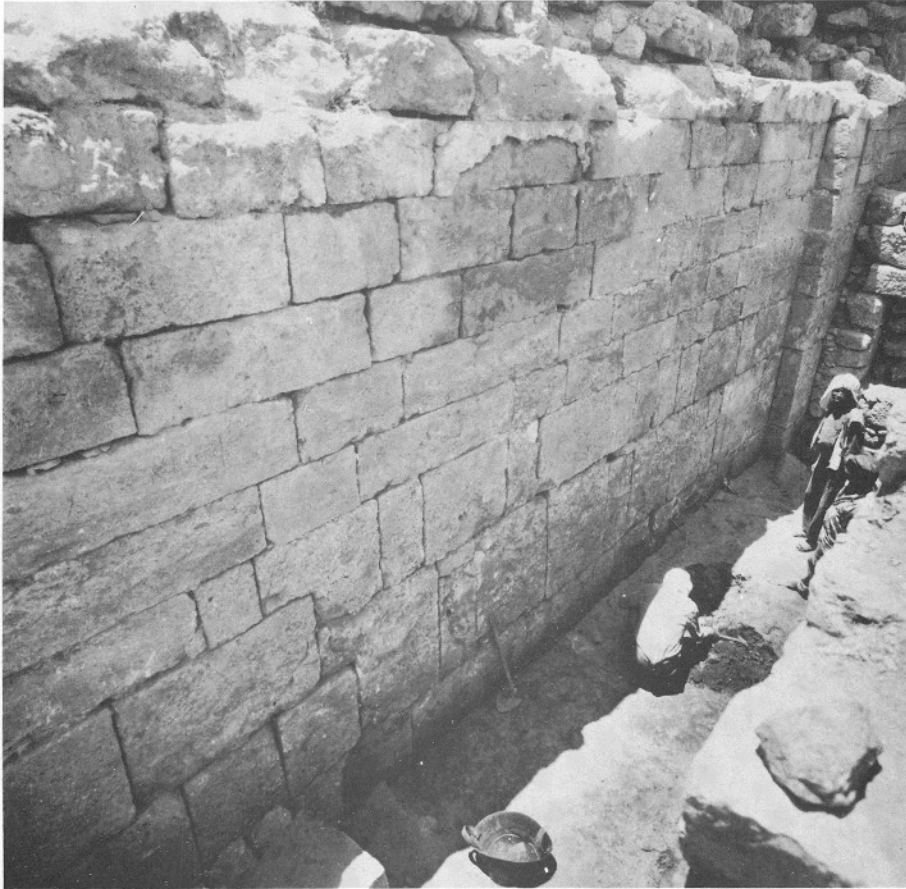
Lám. 14.a.—Vista del paramento del lado sur de la fachada oriental del vestíbulo hacia el corredor E 1.
