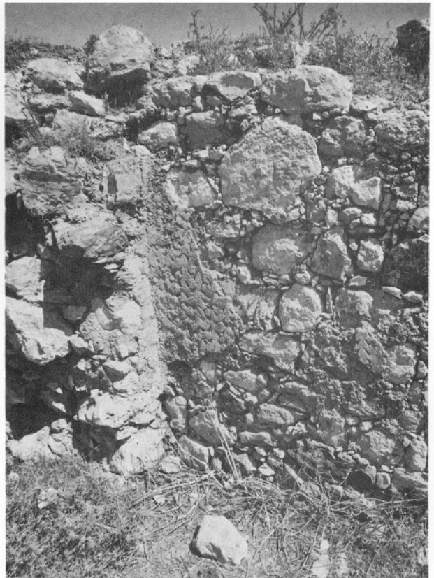
Lám. 53.b.—Restos del enlucido de base en un muro de la parte occidental del área del témenos.
