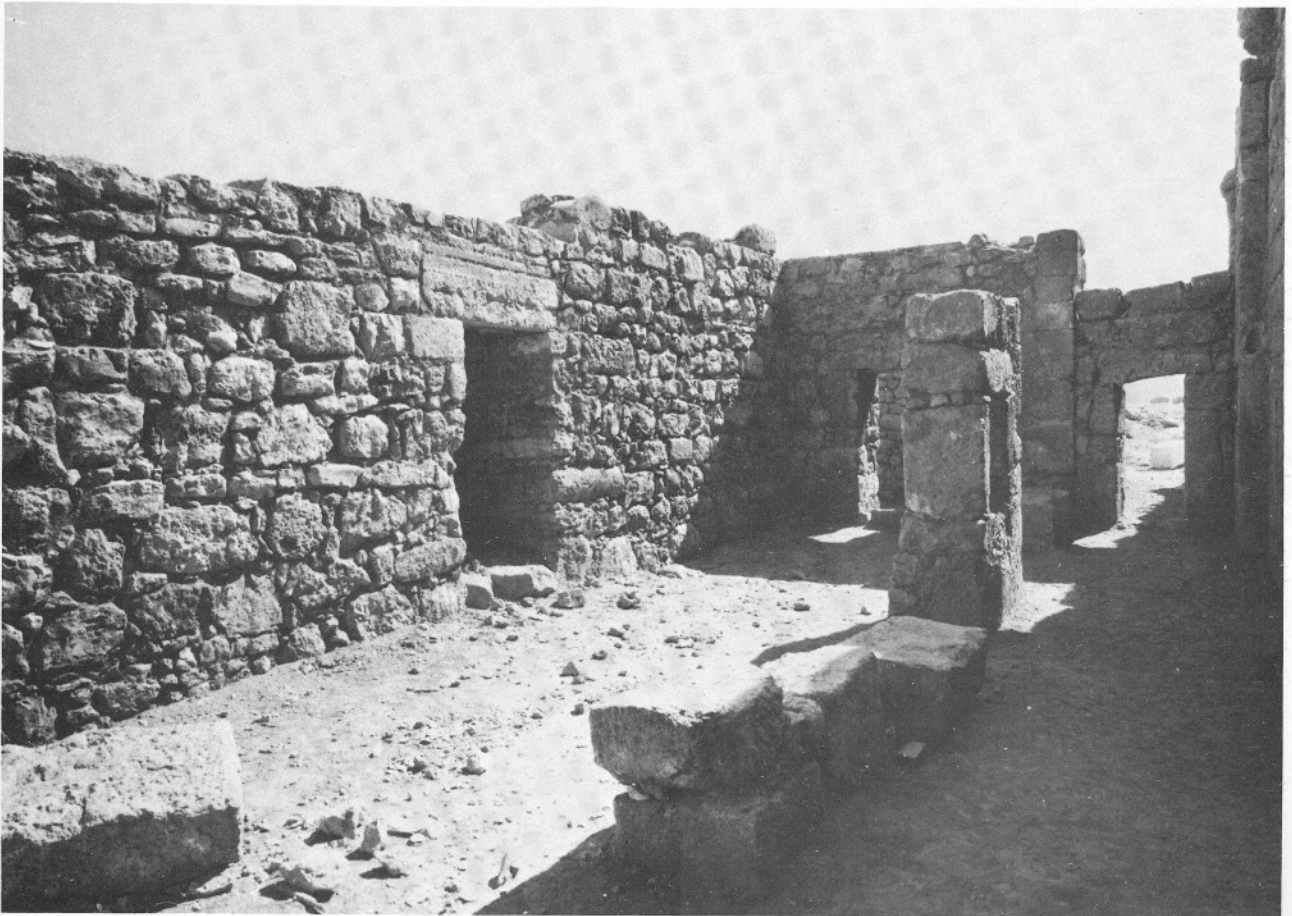
Lám. 33.b.—El patio E 2, desde el pasaje del ángulo noreste del vestíbulo.
