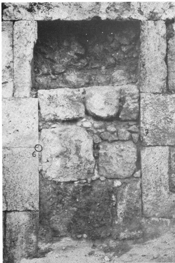
Lám. 24.b.—La puerta de acceso a la escalera antes de eliminar el muro que la tapiaba. لوحة ٢٤ ب - باب الولوج الى الدرج ، قبل ازالة الجدار الذي كان يسده .
