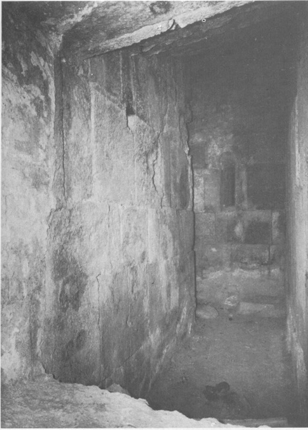
Lám. 27.a.—El primer tramo de la escalera V 4, sin peldaños por haberse transformado en cisterna.
