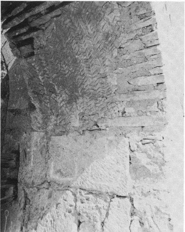
Lám. 53.c.—Detalle de la base del enlucido en el intradós de un arco del pozo de Quṣayr 'Amra.
