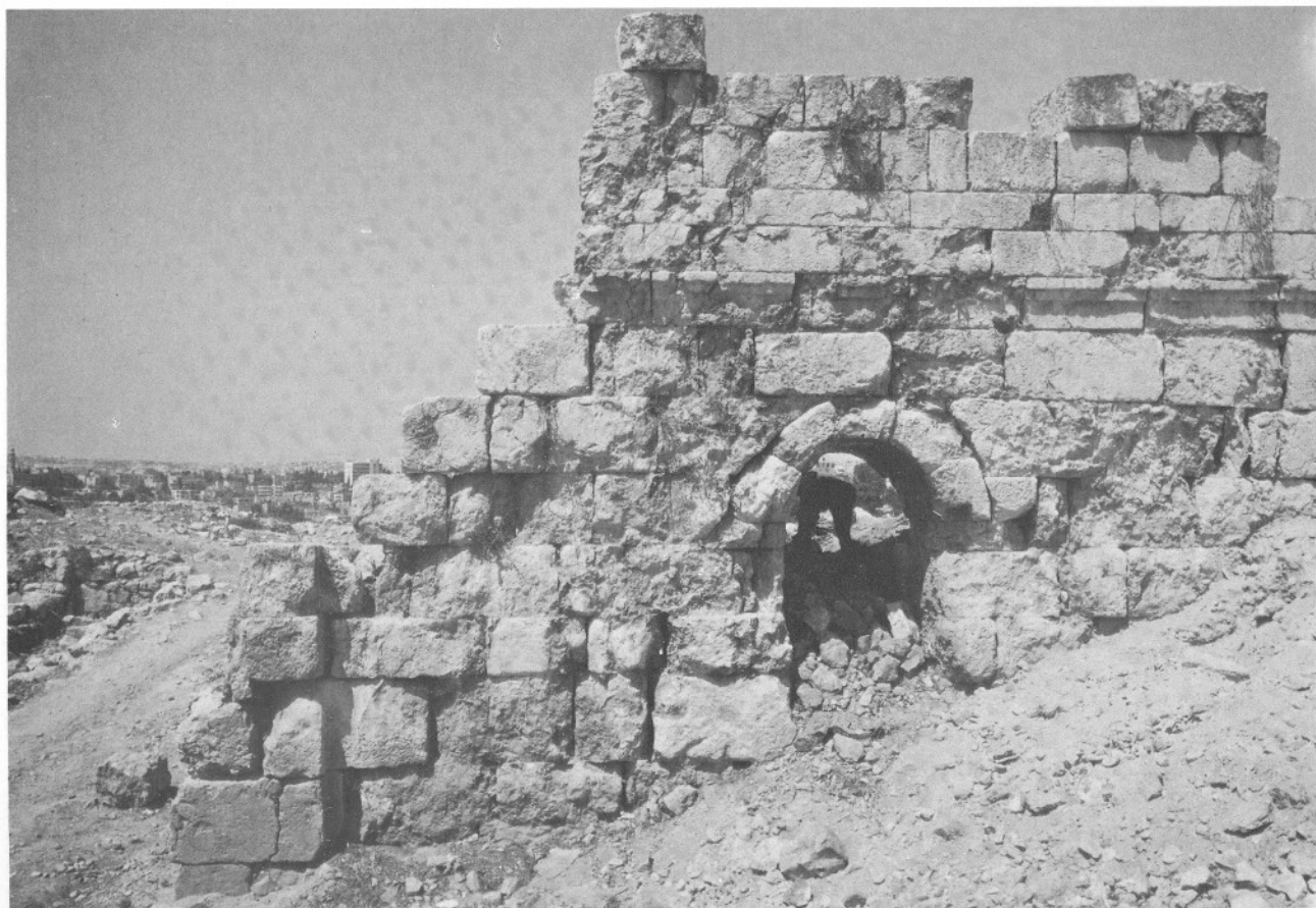
Lám. 58.b.—El iwān N 1 al iniciarse la excavación.
