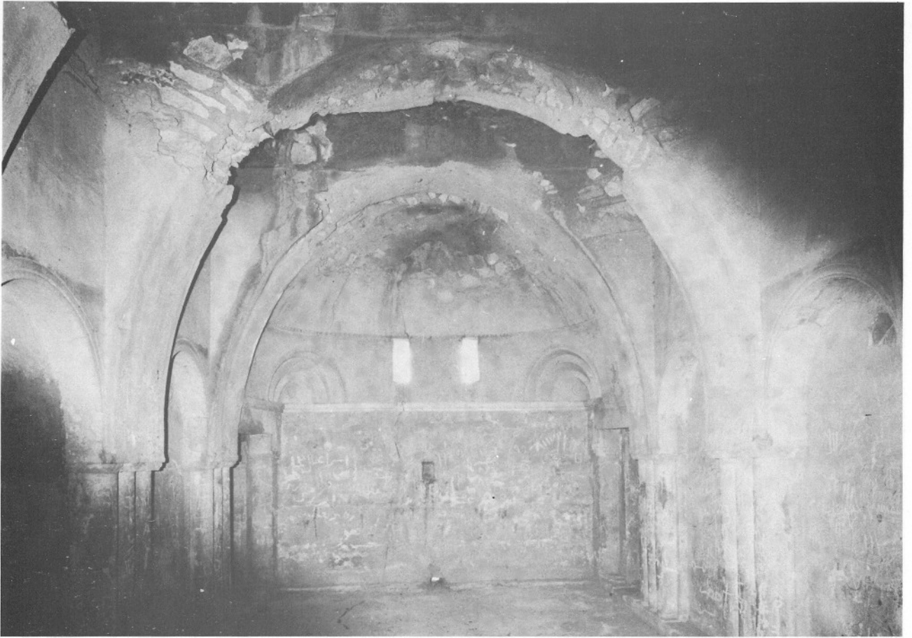
Lám. 30.a.—Uno de los salones del piso alto de Jarāna con la solución de bóveda hemisférica sobre trompas. لوحة ٣٠ أ - احدى صالات الدور الأول في حرانة ، مع القبة النصف كروية فوق عقد الزاوية (الاسقنث).
