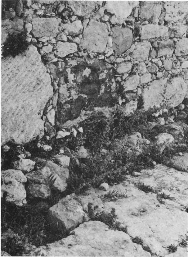
Lám. 53.a.—Detalle de la cimentación del muro de cierre del edificio C sobre el enlosado de la calle porticada.
