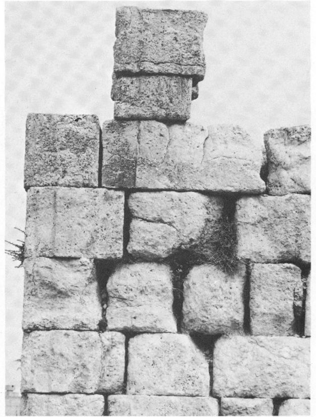
Lám. 44.b.—Parte superior de una pilastra del muro norte del témenos.
