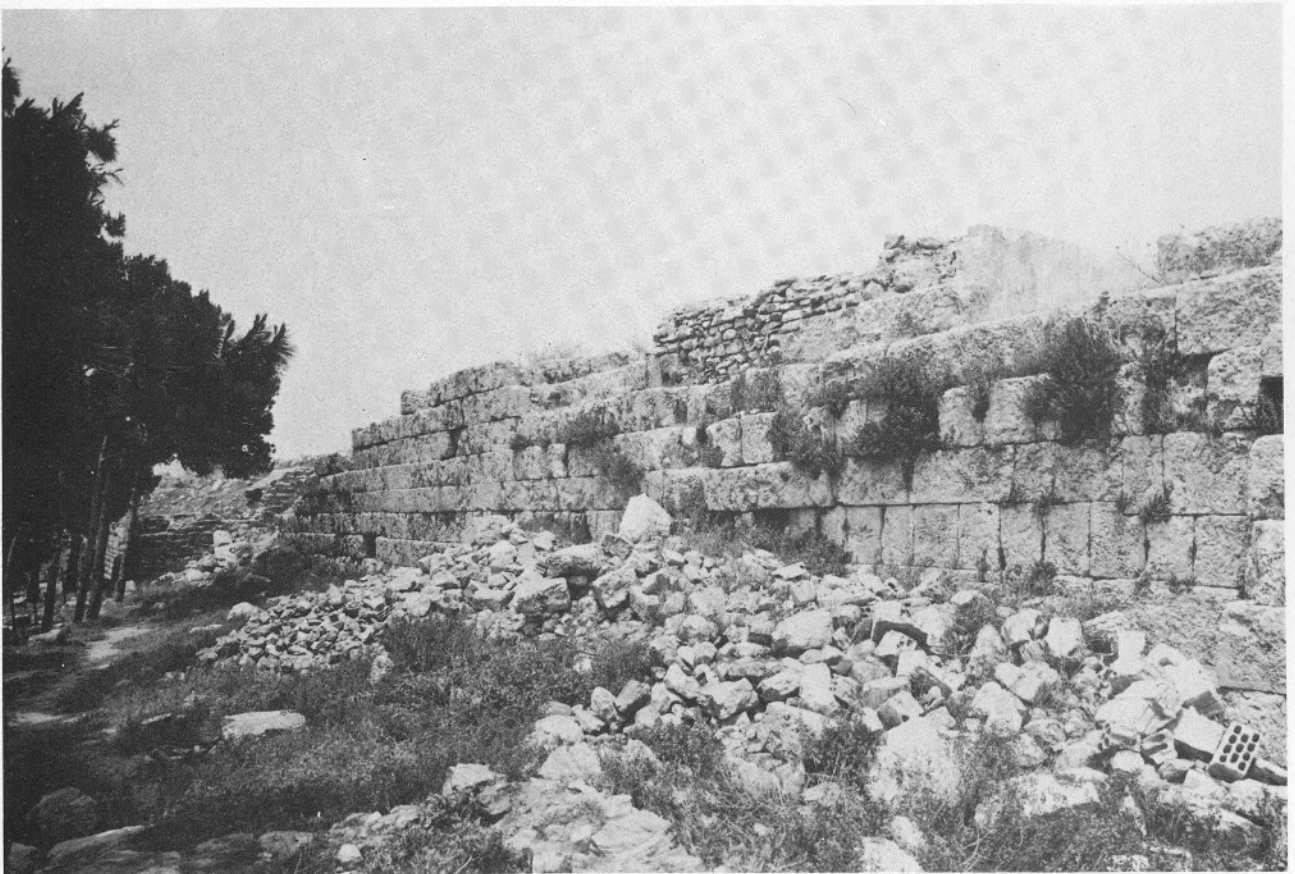
Lám. 7.b.—La muralla occidental al norte de la puerta de este lado. لوحة ٧ ب - تفاصيل السور الغربي عند شمال الباب في هذا الجانب .
