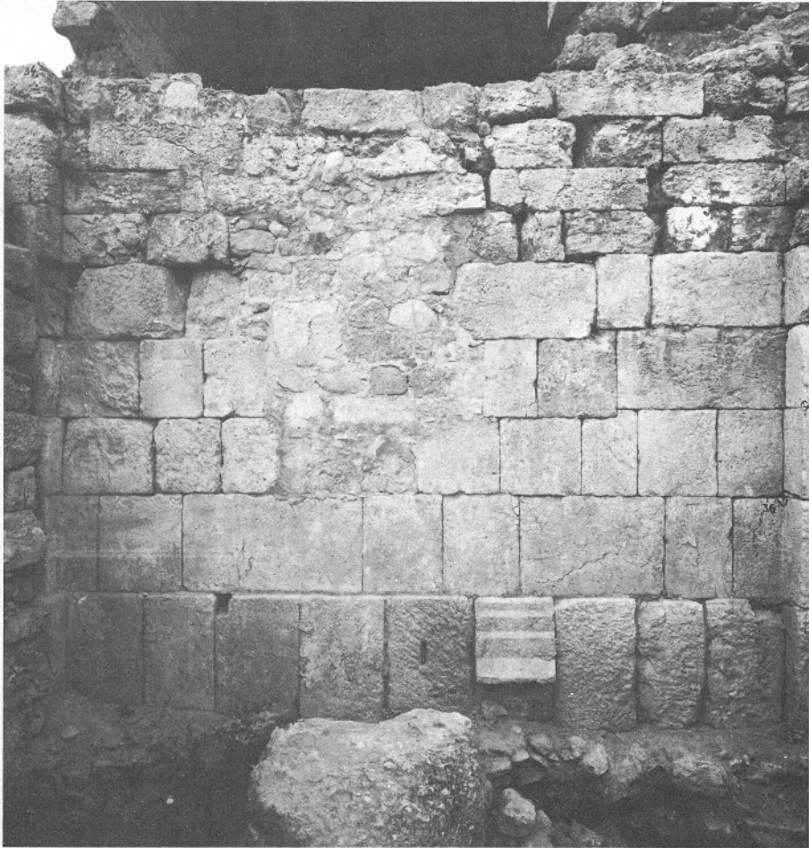
Lám. 12.b.—Detalle de la parte izquierda de la fachada sur del vestíbulo con la cimentación y primera hilada de un edificio anterior.
