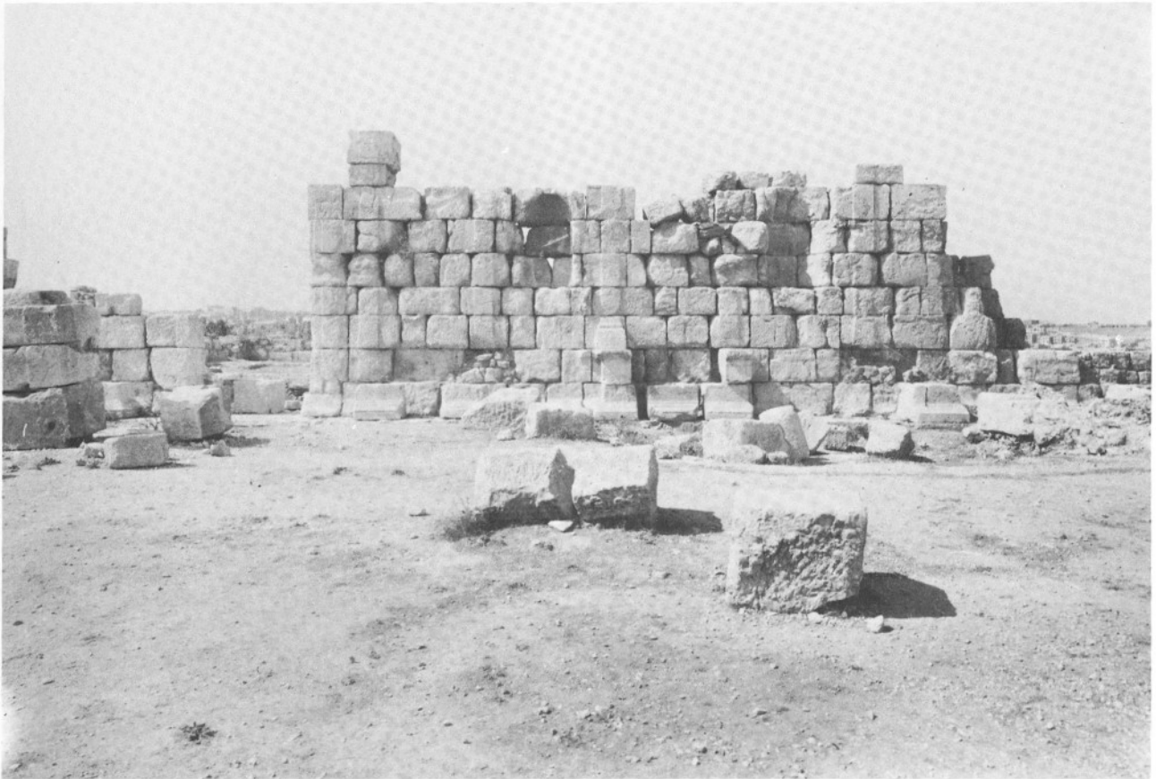
Lám. 43.a.—Parte oriental del muro norte del téménos.
