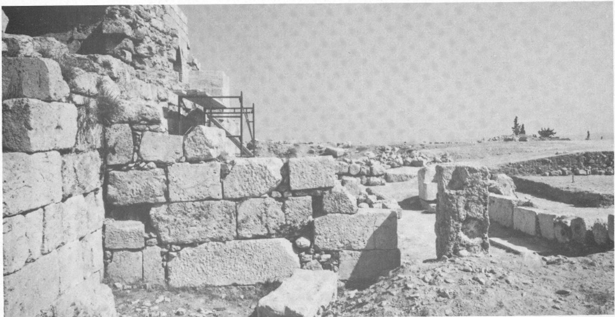
Lám. 31.d.—Detalle del aparejo del muro exterior del sistema defensivo ańadido en el lado sur del vestíbulo. لوحة ٣١ د — تفصيل تشابك الأحجار في جدار الحماية المضاف للديوان .
