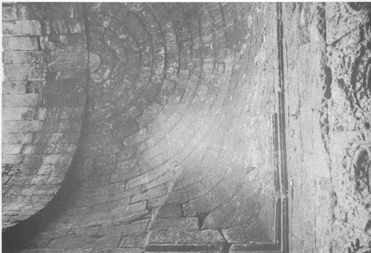
Lám. 23.a.—Vista de la bóveda del brazo oriental del vestíbulo con una de las trompas. لوحة ٢٣ أ - مشهد لقبة الذراع الشرقي للديوان مع اسقنش الزاوية .
