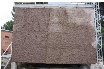
Figura 4: Aspecto final del enfoscado con mortero MorRCDmix
