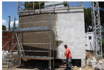
Figura 3: Aplicación del mortero base
