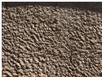
Figura 7: Detalle del mortero MorRCDmix después de 4 años
