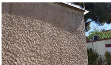
Figura 6: Aspecto del mortero MorRCDmix después de 4 años desde su aplicación
