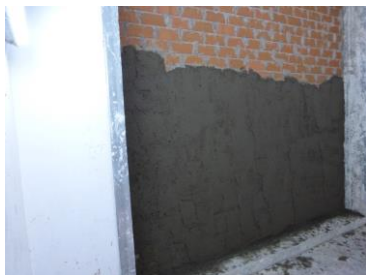
Figura 11: Enfoscado con mortero MorRCDmix de la pared en emision
