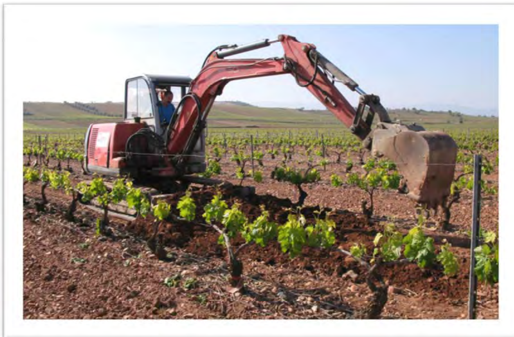
Figura II.15. Apertura de calicata con retroexcavadora.
