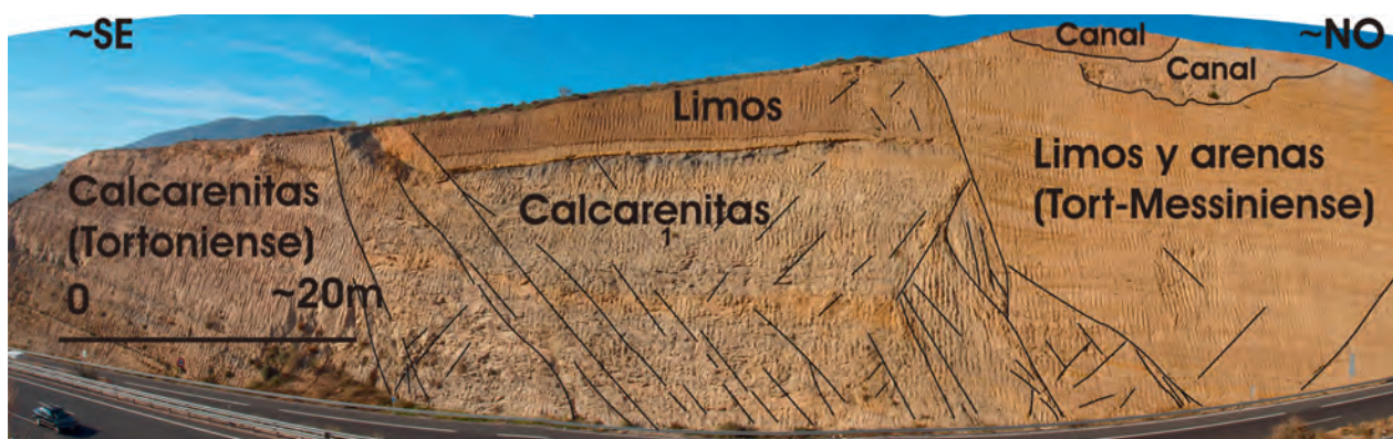
Fig. 5.—Vista general del sector C en el talud de la autovía. Se señalan algunas fallas, todas normales. La curva que se observa en la autovía está exagerada por el montaje de las fotos. Se ha puesto una escala aproximada, aunque en la parte izquierda es algo menor por estar más alejada del punto en que se hicieron las fotos.
