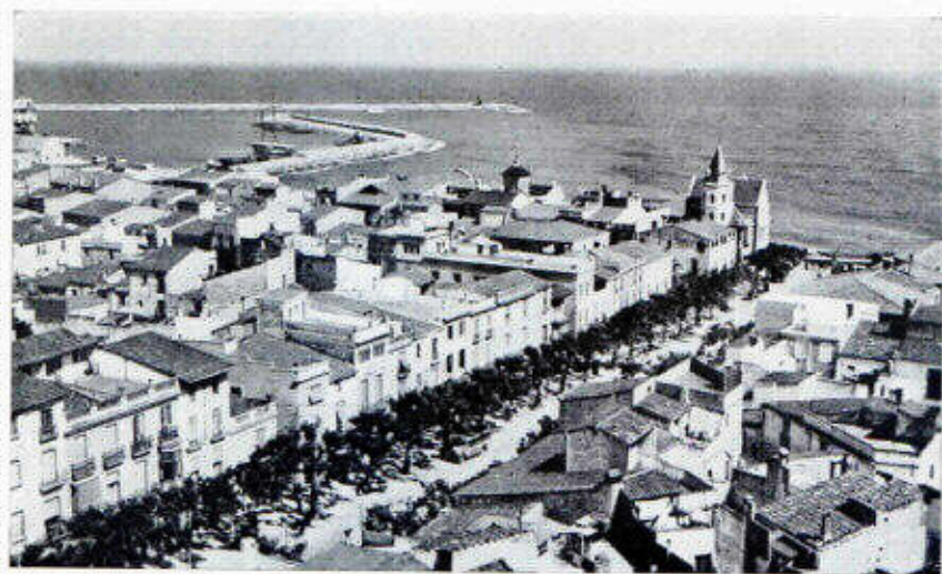
Arenys de Mar. Al fondo, el puerto en construcción
