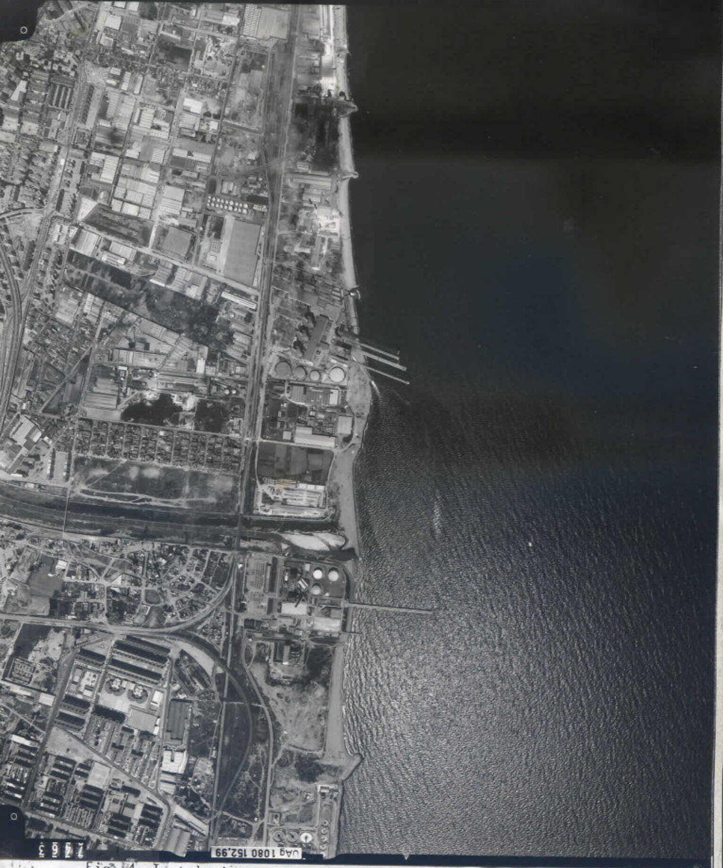
Fig. 4. Instalaciones de toma y descarga de la Central Térmica del Besós.
