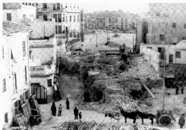
Vista panorámica de los baños de Madre de Dios (Murcia) durante su demolición. Al fondo, el Puente Viejo y el monumento a la Virgen de los Peligros.
