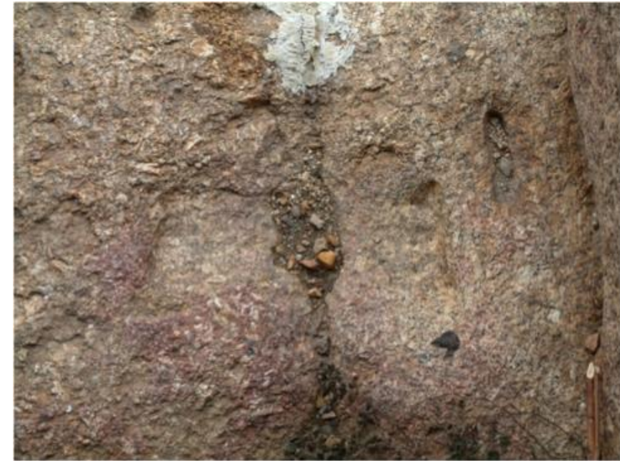
Fig. 17.— Detalle de los orificios rectangulares para la colocación de palancas funcionales al posicionamiento de los sillares en el paramento del estribo del puente sobre el río Guadiana en Mérida
