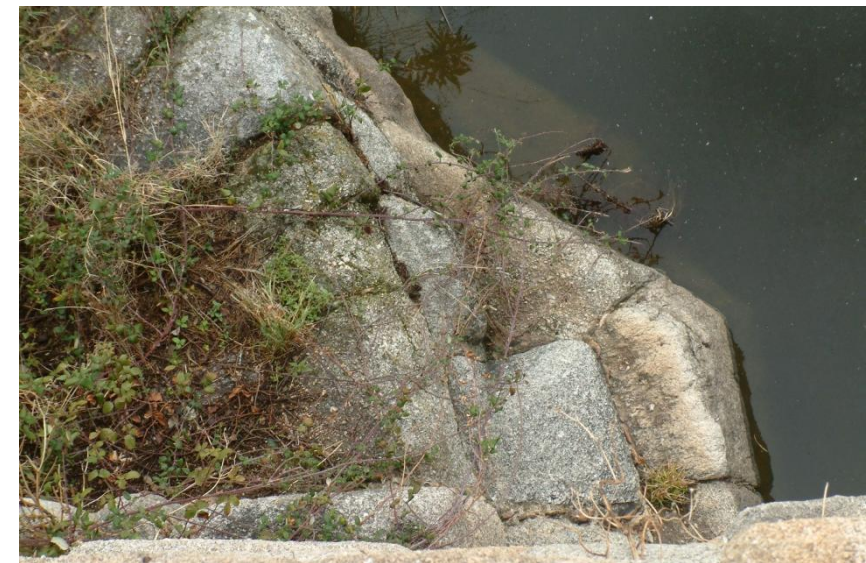
Fig. 4.— Tajamares de planta semicircular del segundo tramo del puente del Guadiana añadidos posteriormente a una restauración de algunos arcos. Prueba evidente de una fase que no corresponde a la original
