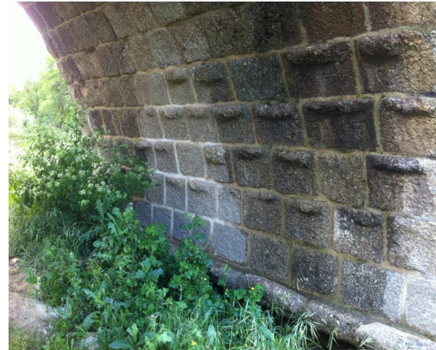
Fig. 10.— Arranque de bóveda del primer arco del puente de Vila Formosa
