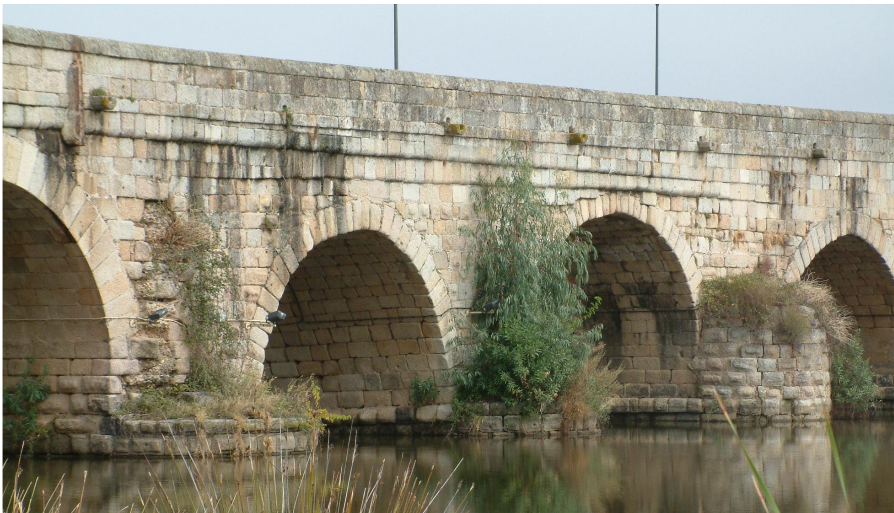
Fig. 3.— Tajamares de planta semicircular añadidos en el tramo II del puente sobre el río Guadiana
