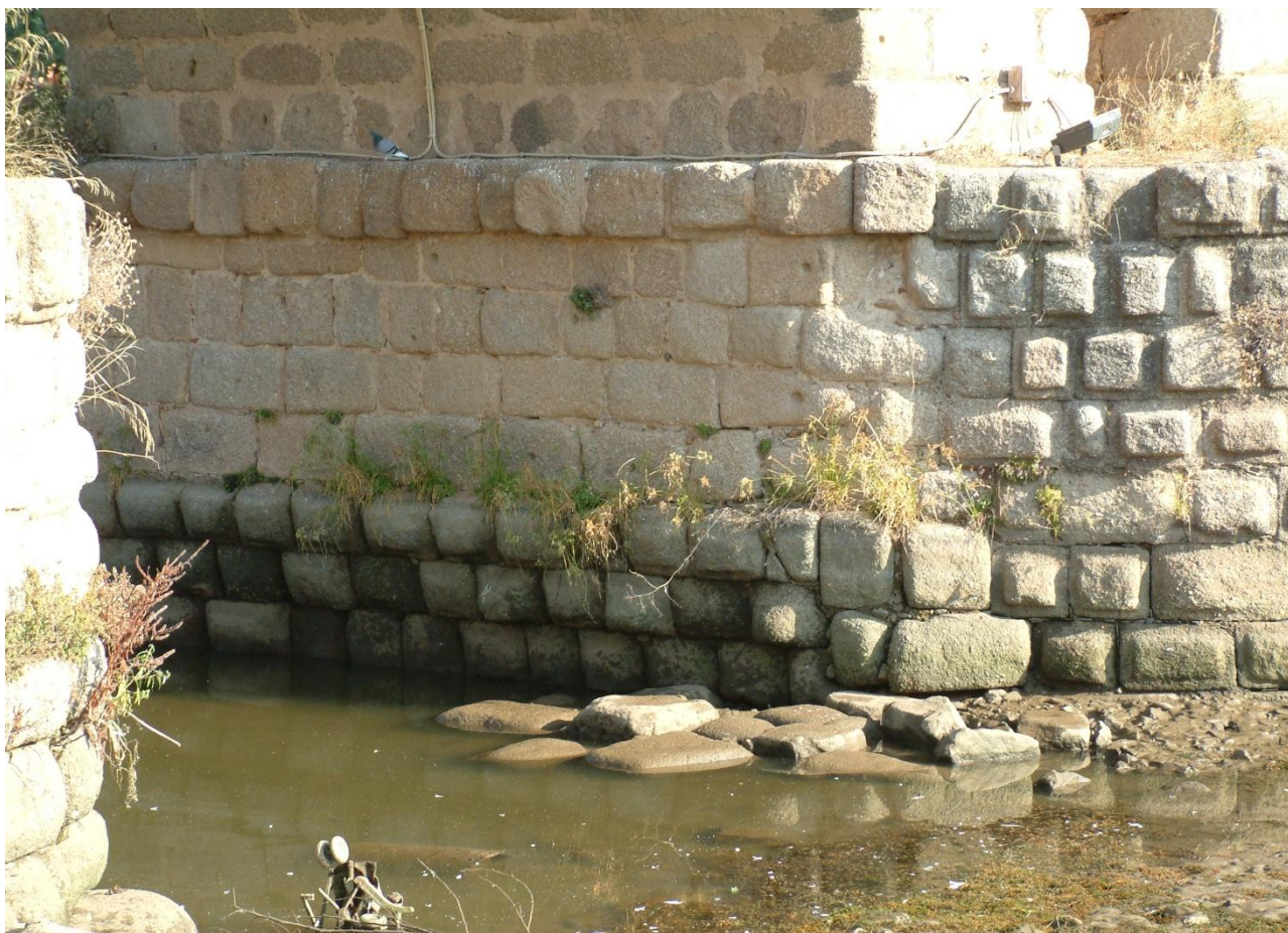
Fig. 2.— Detalle de los elementos constructivos anteriores a la sustitución de los tajamares triangulares con estructuras de planta semicircular
