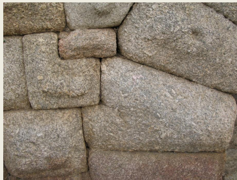
Fig. 5.— Arco y detalle de los engastillados en la última ampliación en la orilla sur del puente sobre el río Guadiana
