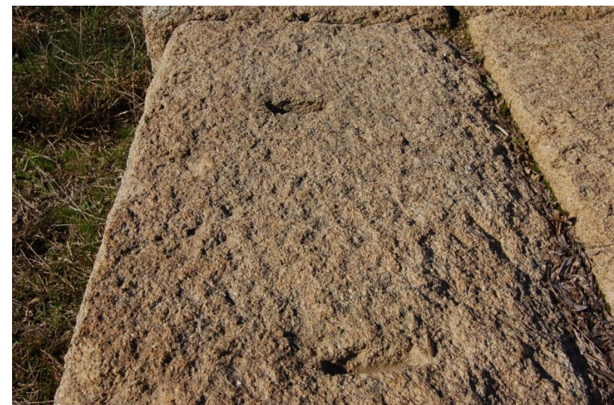
Fig. 16.— Detalle de los orificios rectangulares para la colocación de palancas funcionales al posicionamiento de los sillares en el paramento del estribo del puente de Aljucén
