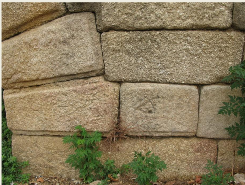
Fig. 5.— Arco y detalle de los engastillados en la última ampliación en la orilla sur del puente sobre el río Guadiana
