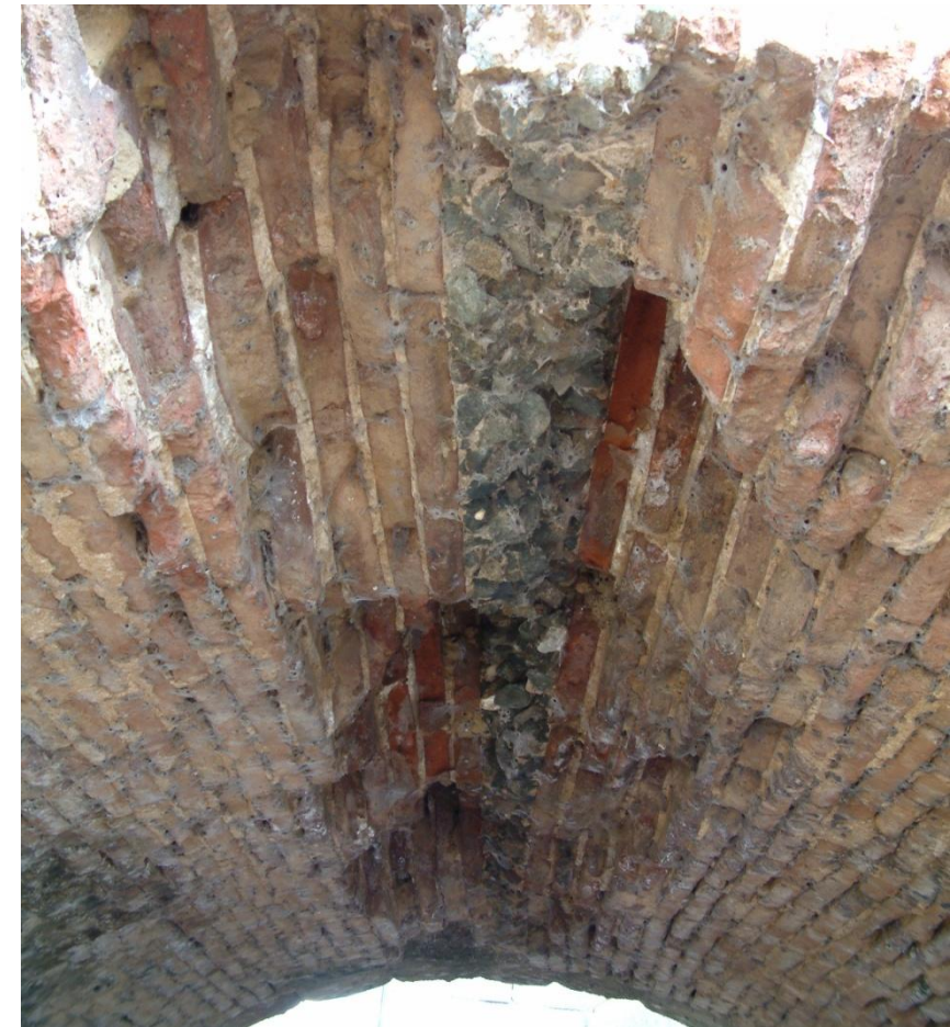
Fig. 7.— Detalle de la clave irregular en opus caementicium del arco de “la Alcantarilla” de Mérida
