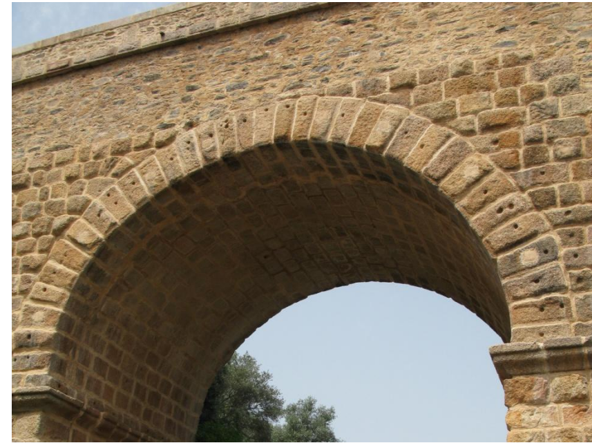
Fig. 19.— Detalle del arco original conservado en la orilla portuguesa del puente de Segura, con la presencia de dobles orificios de tenazas en las dovelas debido a errores e cálculo en el posicionamiento de los bloques en la cimbra
