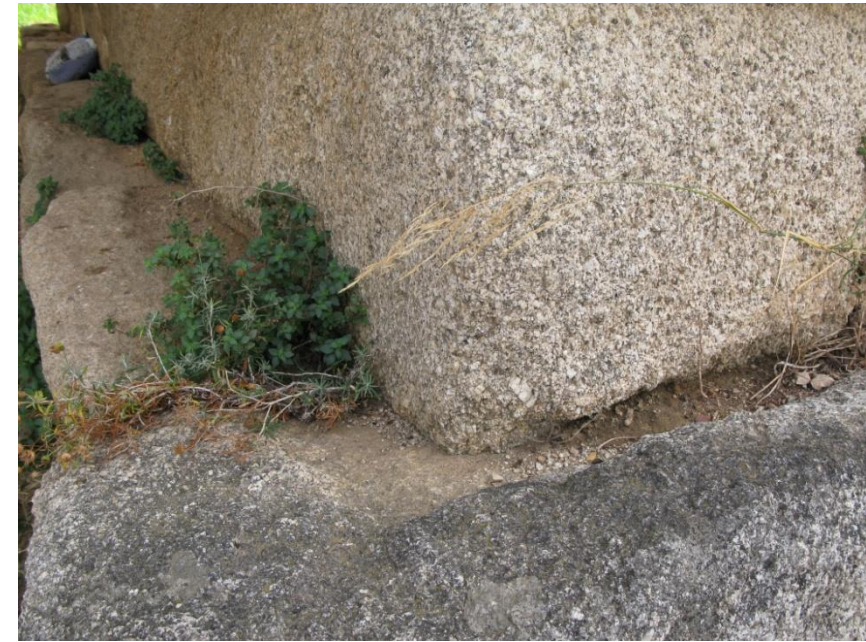
Fig. 13.— Incisiones perpendiculares que marcan los arranques de los arcos en las primeras ampliaciones del tercer tramo del puente sobre el Guadiana
