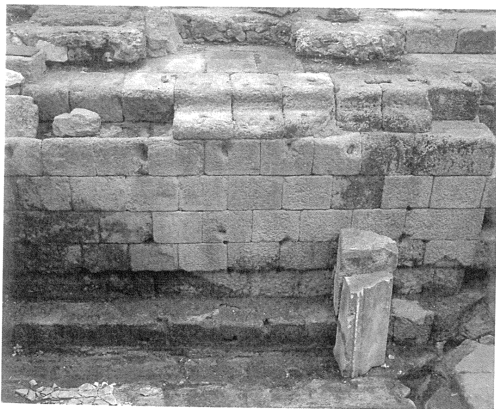
FIGURA 20. Paramento del podio del templo.
