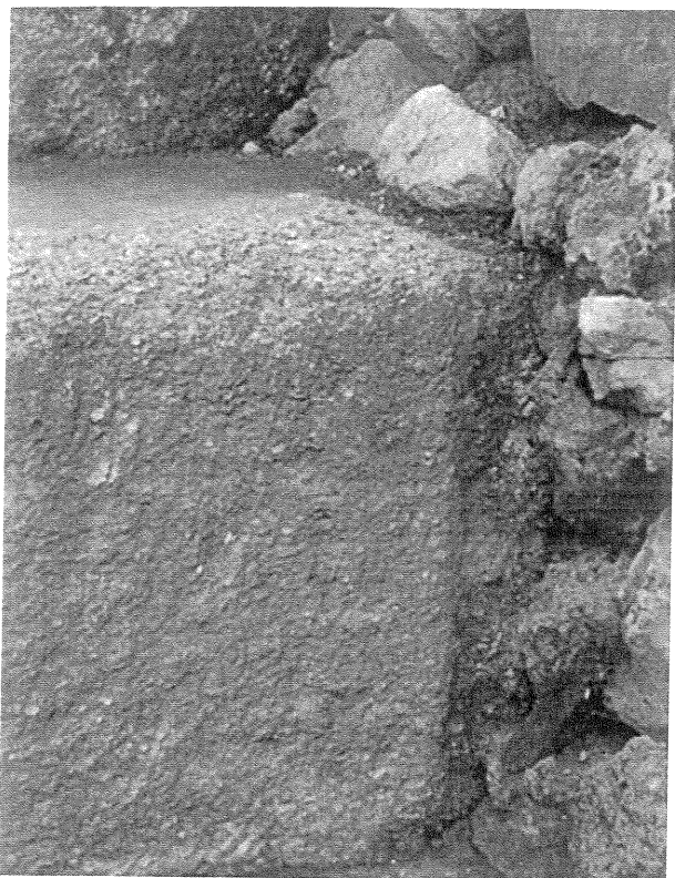
FIGURA 19. Detalle del punto de contacto entre el bloque de granito del paramento y el núcleo en opus caementicium del podio del templo.
