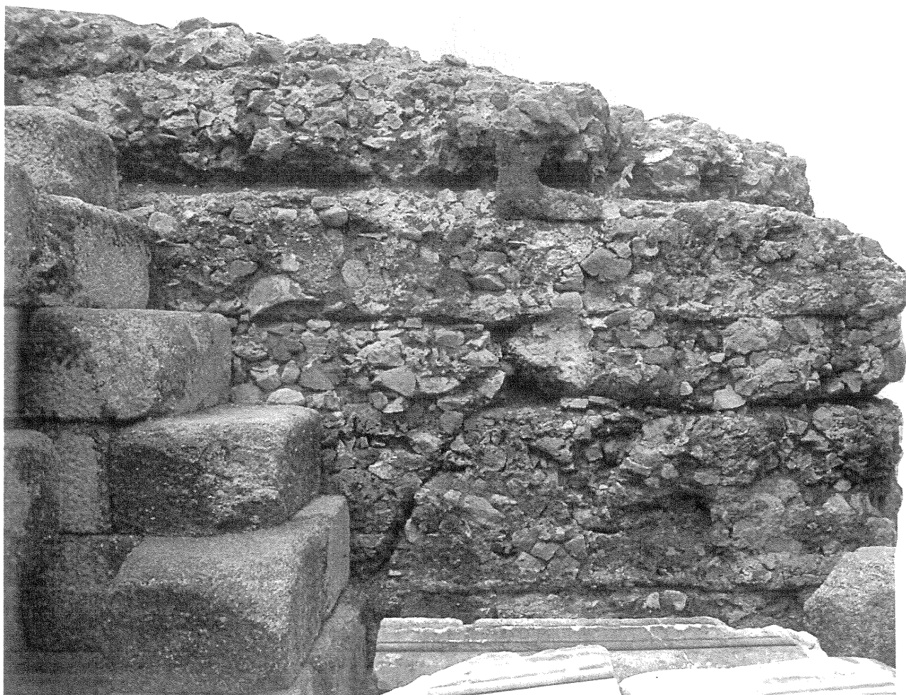
FIGURA 18. Fases de obra en la construcción de la parte en opus caementicium del podio del templo.
