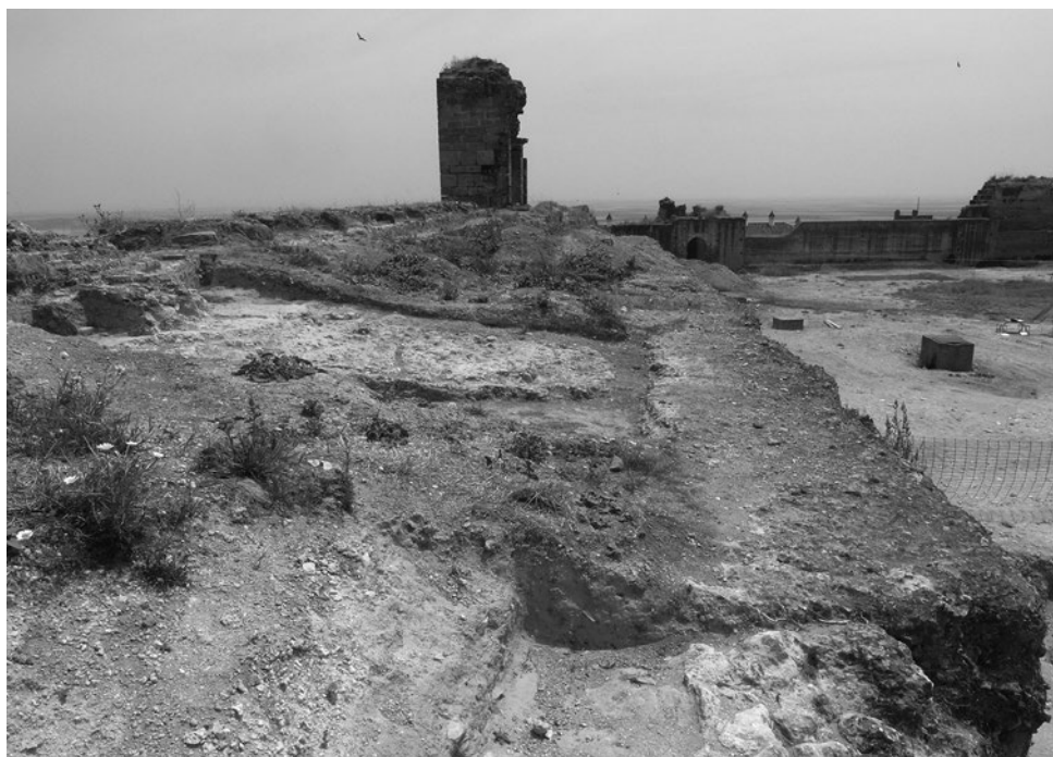
Figura 16. Estado actual de la Sala de los Reyes del palacio. Foto A. Almagro.
