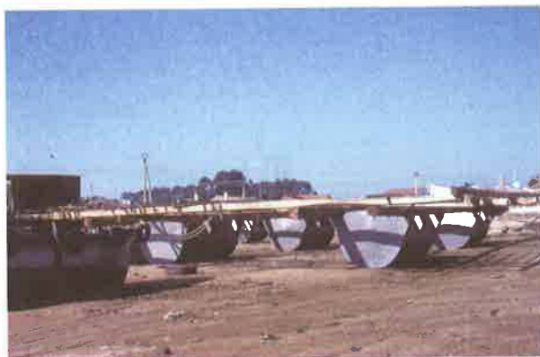
Figura II.6. Construcción de bateas con flotadores metálicos.
