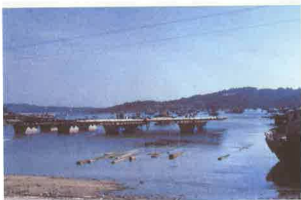
Figura II.5. Construcción de bateas aprovechando la bajamar.
