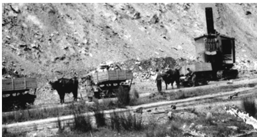
Figura 5: Las vagonetas de tiro animal mejoró el transporte de las materias primas (Varas et al, 2007; Ibáñez et al, 2001).
