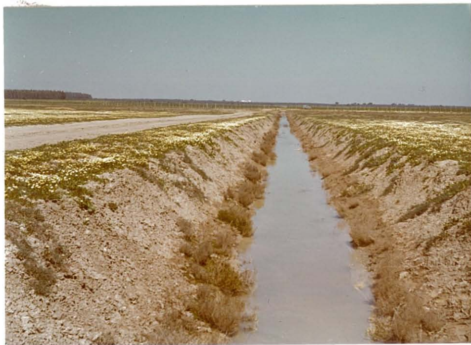
Fot. Nº 4 - Canal de drenaje realizado en el área que comprende las zonas de estudio nº 1 y 2. Abril 1972.
