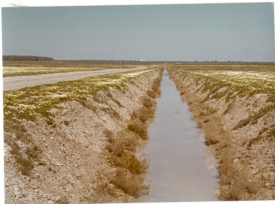
Fot. N° 4 - Canal de drenaje realizado en el área que comprende las zonas de estudio n° 1 y 2. Abril 1972.
