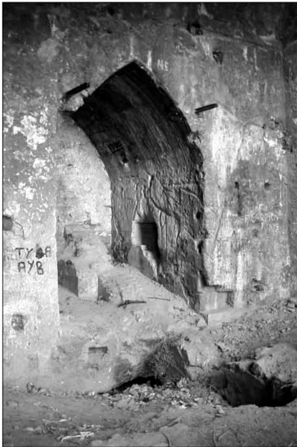
Restos de la posible bancada donde descansasen las piedras de moler del Molino del Cubo
