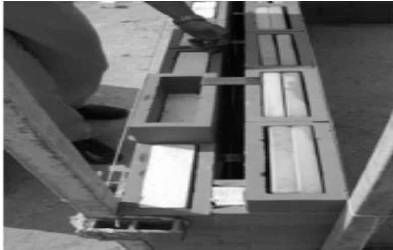
Fig. . 4 Vista parcial durante la construcción de una de las casetas , formado por piezas cerámicas conteniendo el aislante poliestireno y el PCM en piezas plásticas , las temperaturas de cambio de fase eran alternativamente de 20 y 26 °C en la primera capa y de 23 °C en segunda (la interior de la caseta).
