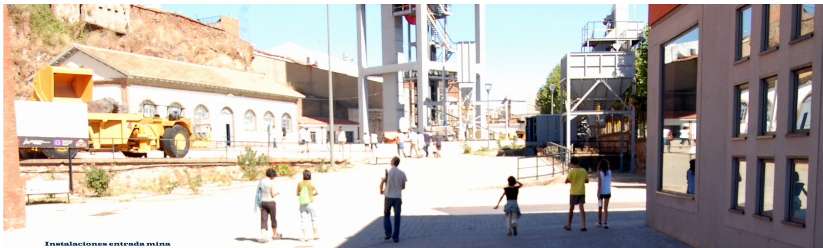
Instalaciones entrada mina
