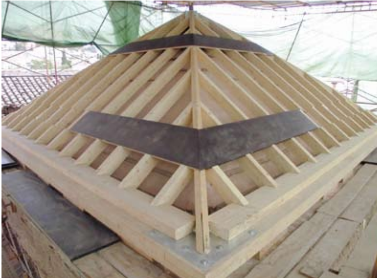
Figura 6 .- Cuarto Real de Santo Domingo. Colocación de nuevos estribos y sobrecubierta de madera laminada, durante las obras de restauración de 2002-04.
