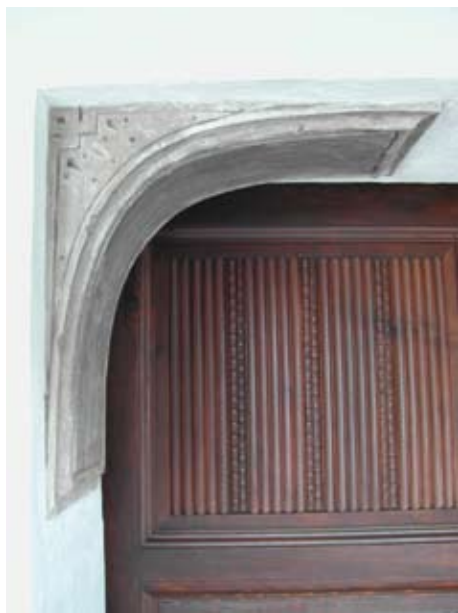
Figura 14.- Casa en el Callejón de San Luís Alto, nº 9. Ménsula de yeso en la puerta de la sala alta norte.
