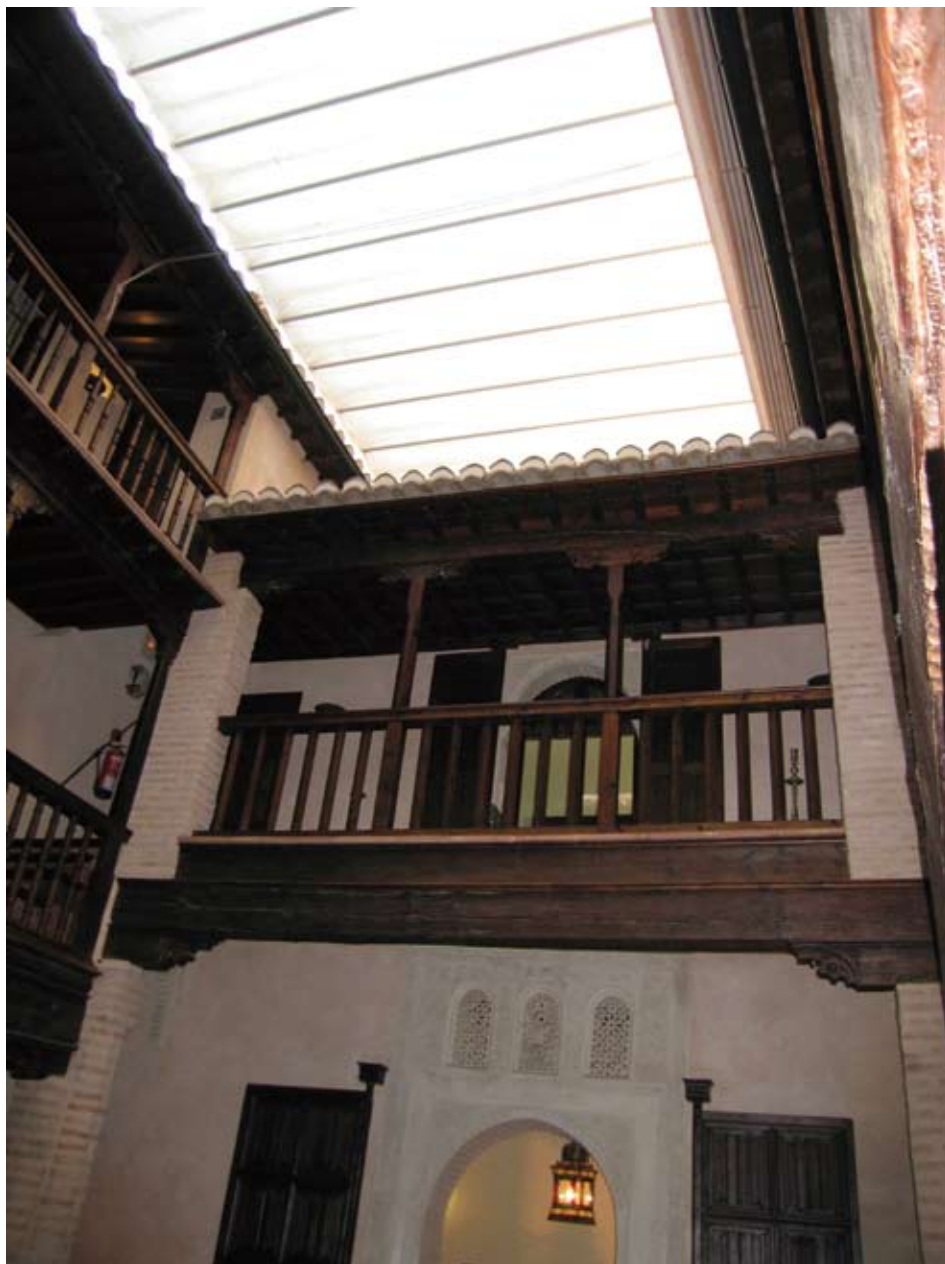
Figura 16.- Casa en la Cuesta de la Victoria, nº 9. Colocación de un toldo de fibra plástica sobre otro tradicional en la intervención del año 2001, para facilitar la climatización del patio.
