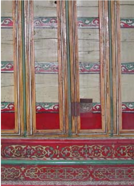
Figura 11.- Casa en la Cuesta de las Tomasas, nº 12. Prueba de retirada de pintura moderna en la armadura de la sala alta norte, repintada en la década de 1970.
