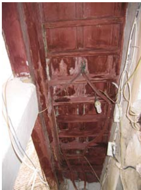
Figura 5 .- Casa morisca en la Calle de San Martín, nº 16. Alfarje del pórtico norte con jácena suplementaria para sujetar las viguetas deterioradas.
