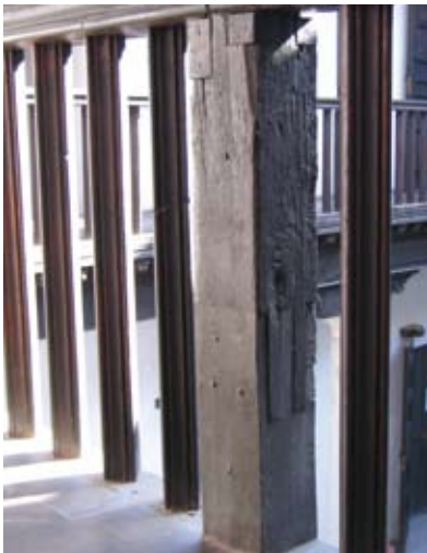
Figura 9 . - Casa del Chapiz. Restauración de la parte baja de un pie derecho en la galería norte del patio septentrional, dirigida por Torres Balbás en 1930-32.
