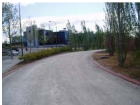
Base del firme realizada con árido reciclado.
