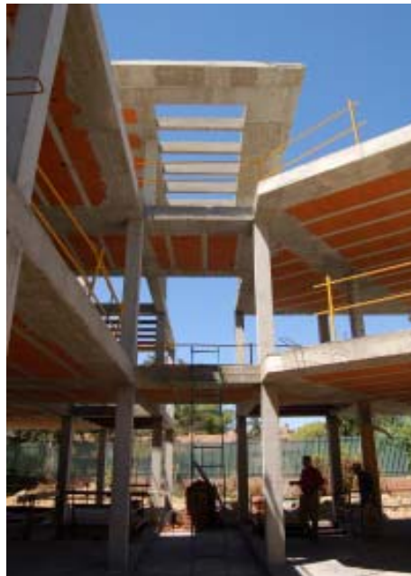
Estructura realizada con hormigón de árido reciclado. Proyecto Tato.
