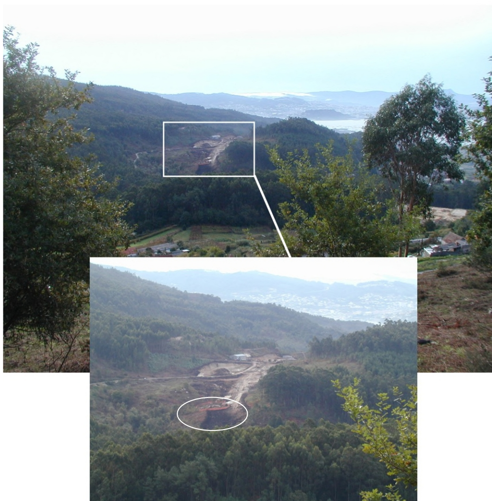
Figura 4. Arriba: fotografía aérea da situación orixinal (en azul) da rocha antes e despois da construción do corredor e da súa situación actual (en vermello). Abaixo: vista desde o NW do emprazamento do petróglifo de Devesa do Rei
