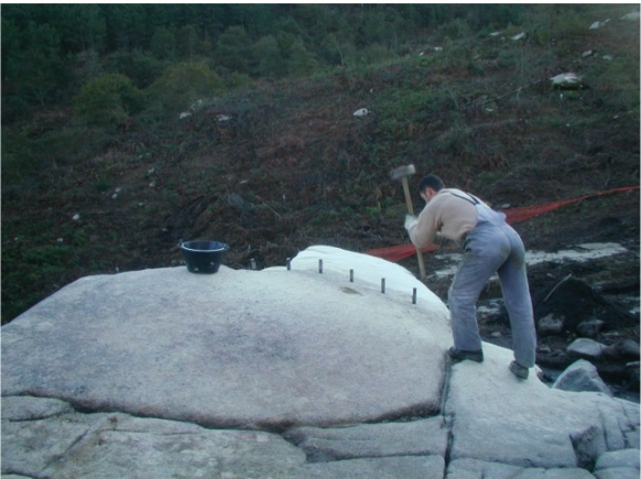
Figura 29. Arriba: Extracción con máquina escavadora das pedras exentas situadas no contorno do petróglifo. Abaixo: Traballos de barrenado previos á extracción do bloque que contén o círculo con apéndice e o motivo semicircular
