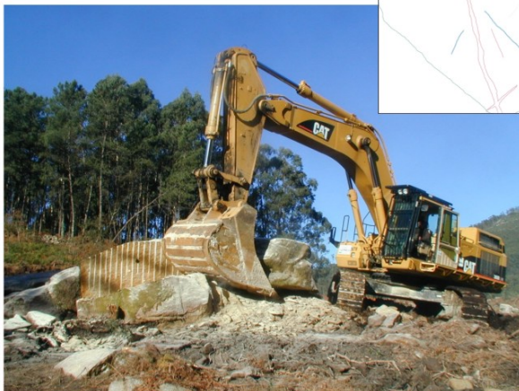
Figura 30. Nas dúas fotos de enriba amósase o estado da rocha tralos traballos de barrenado e de inserción de cemento expansivo. Abaixo: Traballos de extracción dun dos bloques da parte leste (en amarelo no calco), na última foto móstrase o estado da rocha despois da extracción.
