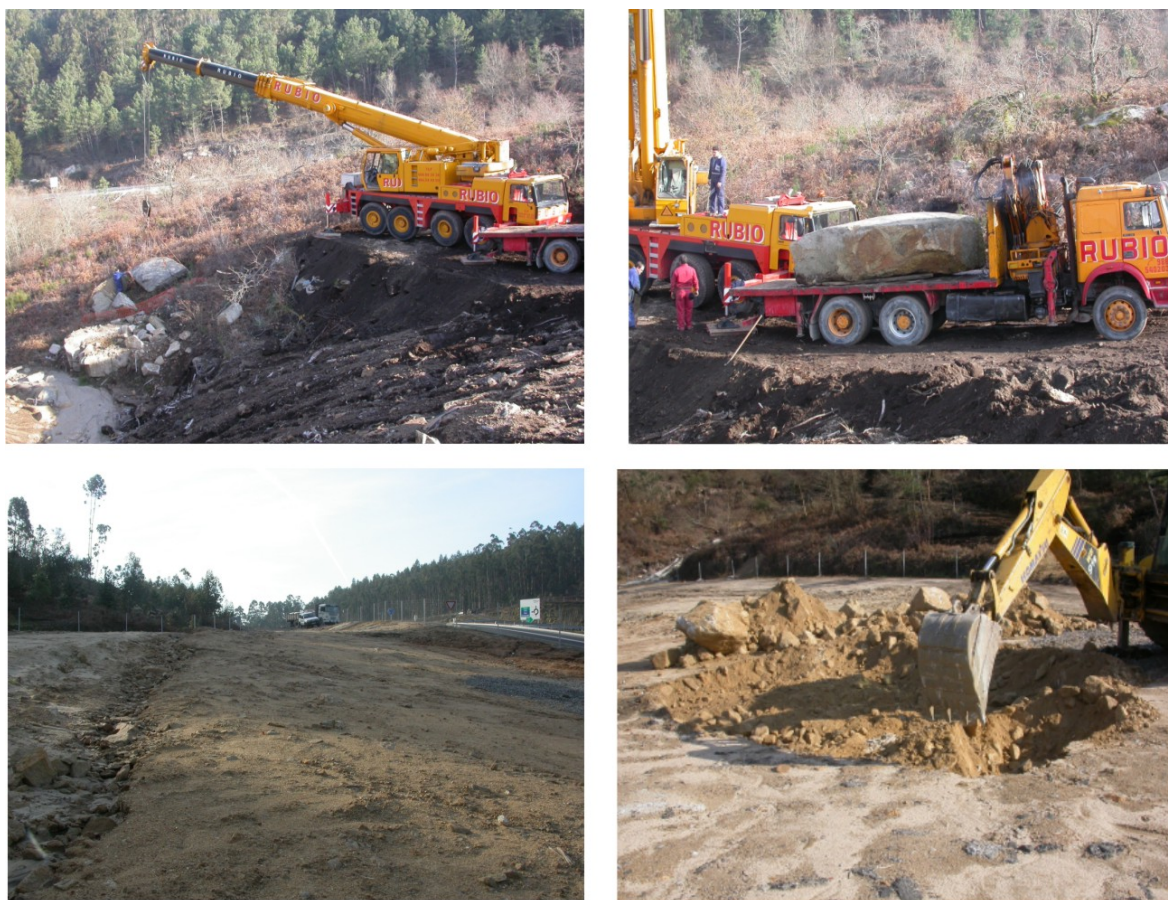
Figura 34. Traslado da rocha ao novo lugar de reubicación e preparación do mesmo
