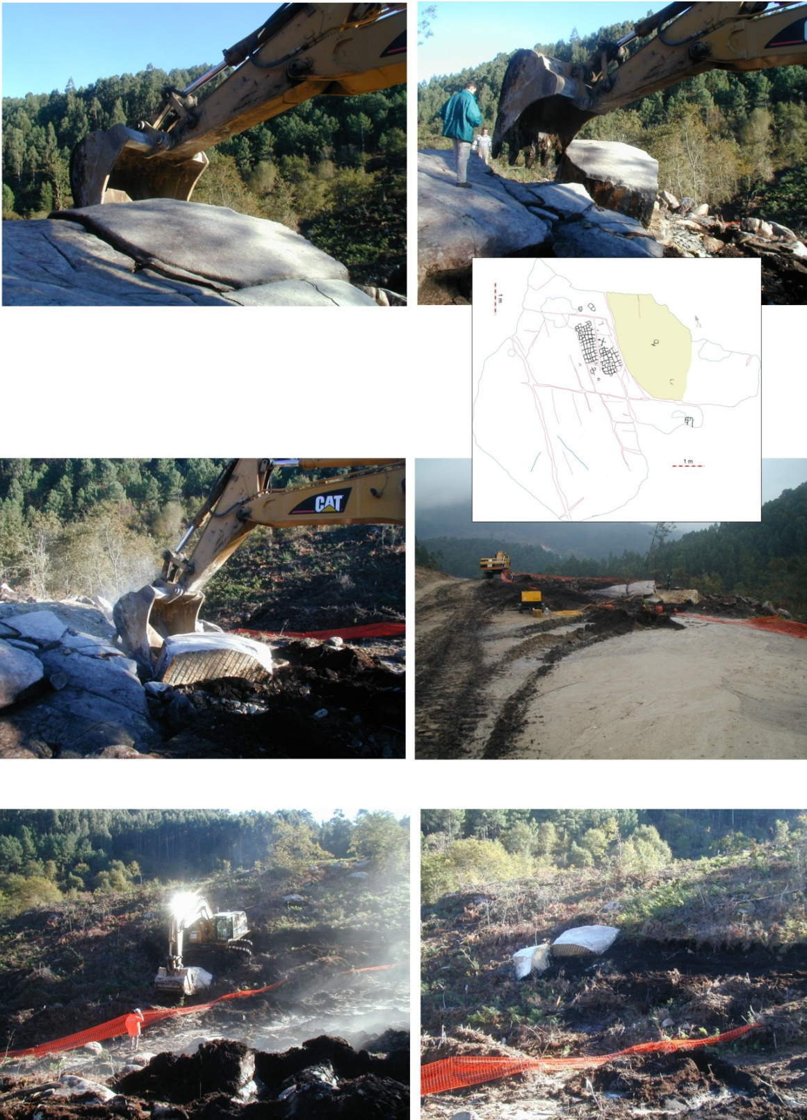
Figura 31. Nas fotos de enriba amósase a extracción do segundo bloque da parte leste e estado da rocha tras a extracción dos dous bloques. Nas dúas fotos inferiores amósase o traslado e depósito dos dous bloques nun lugar provisional
