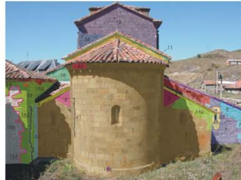
Nesta foto, cada cor é unha unidade estratigráfica que responde ás diversas fases construtivas
