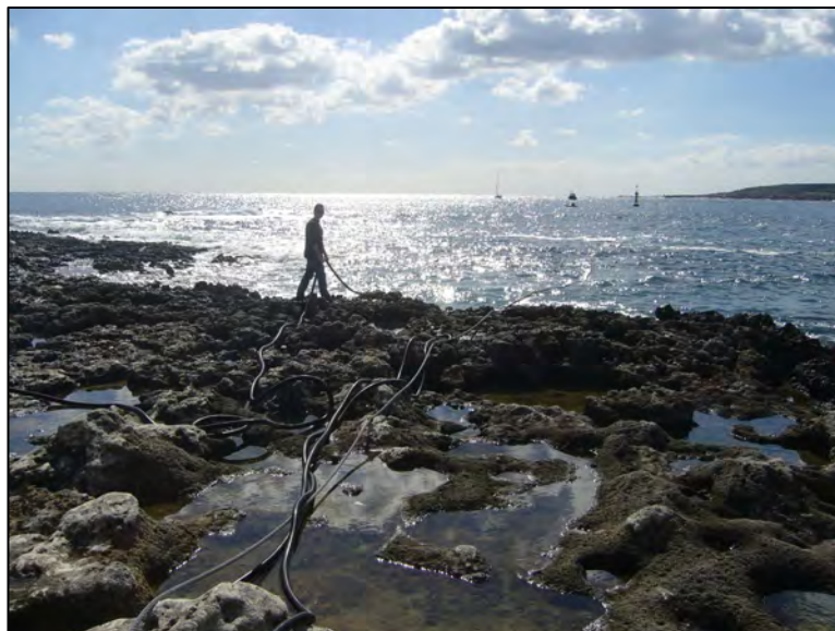
Foto 3: Imagen de la instalación de los cables en la entrada al mar
