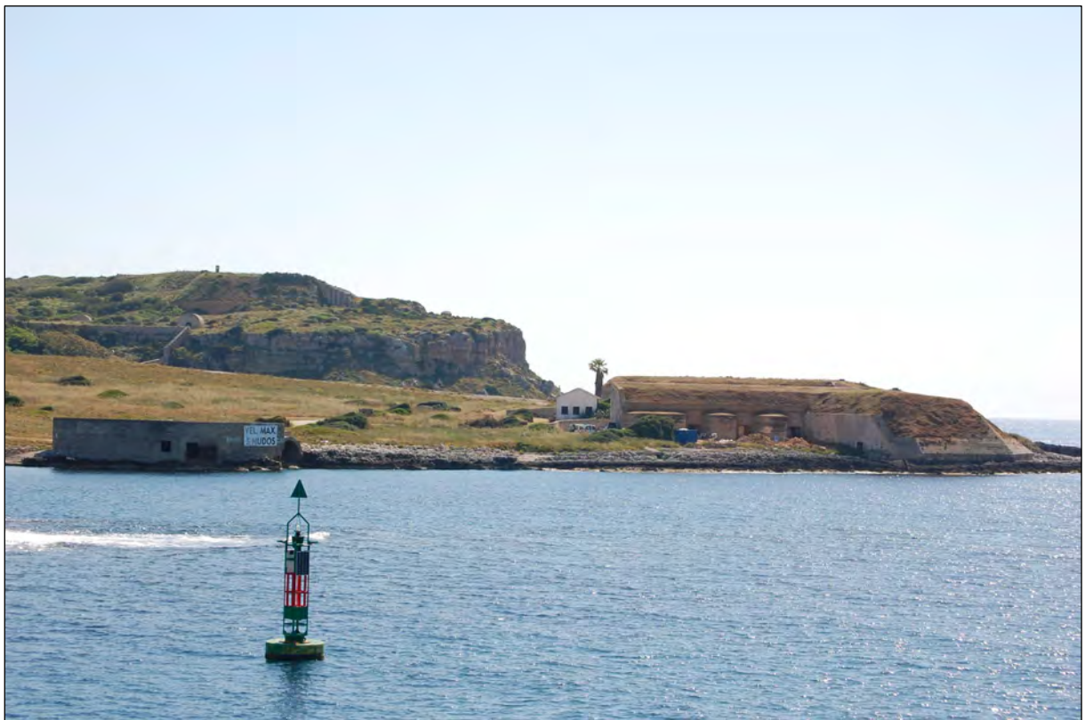
Foto 1: Vista general de la Estación Jaume Ferrer, La Mola
