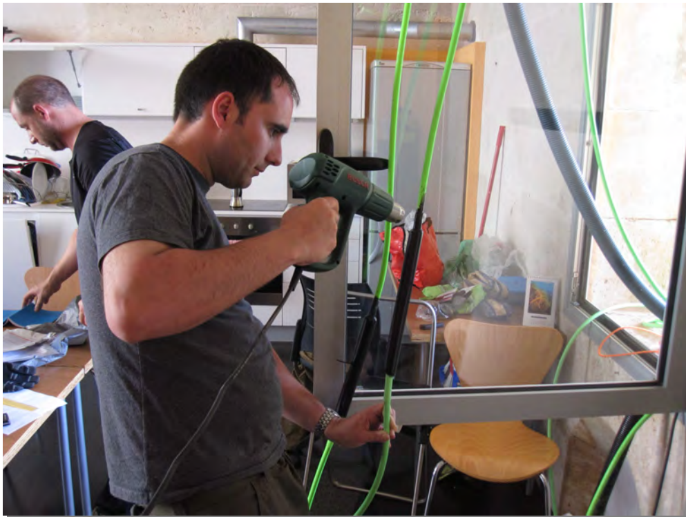
Foto 5: Detalle del encapsulado de los cables tras la reparación
