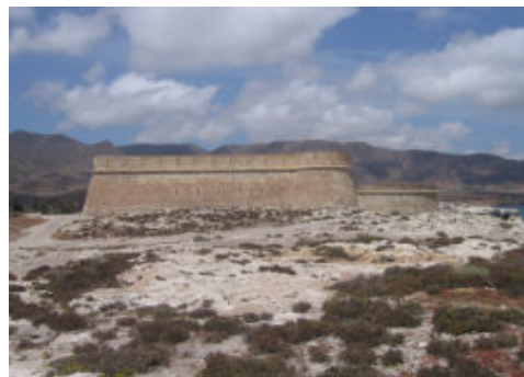
Fig. 4- Fuerte de los Escullos visto desde el sur (foto por Antonio Orihuela, 2008)
