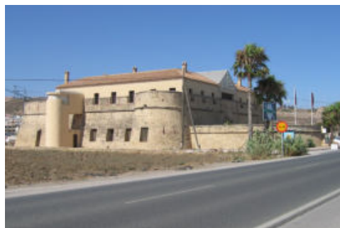
Fig. 8- Fuerte de Valleniza, renovado para albergar una Escuela de Hostelería (foto por Antonio Orihuela, 2007)
