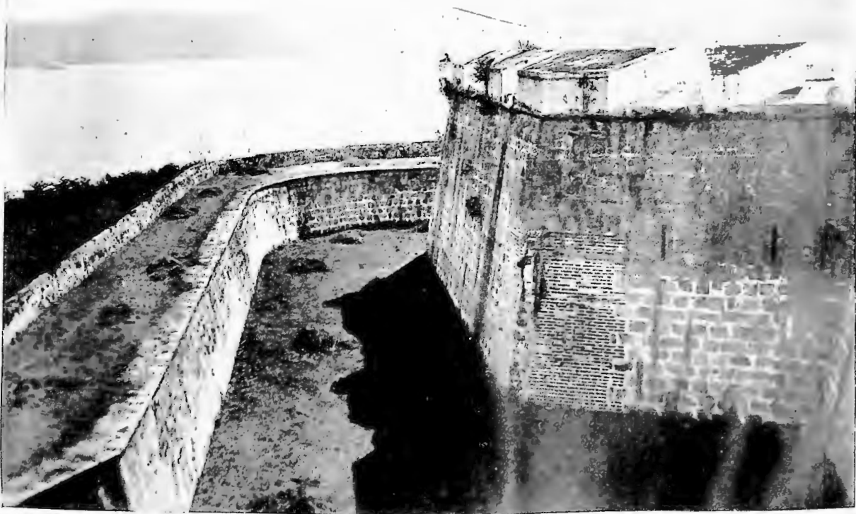
FIGURAS 173 Y 174.—VISTAS DE DOS BALUARTES, FOSO Y CONTRAESCARPA DEL CASTILLO DE ACAFULCO
