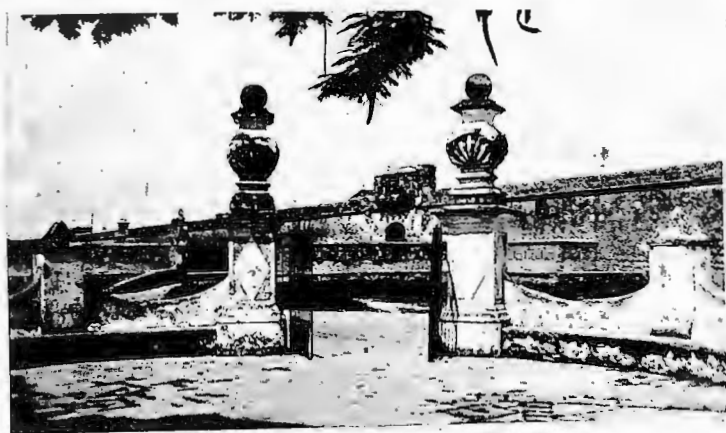
FIGURA 90.—LA PUERTA DE TIERRA DESDE LA ALAMEDA DE TORO
