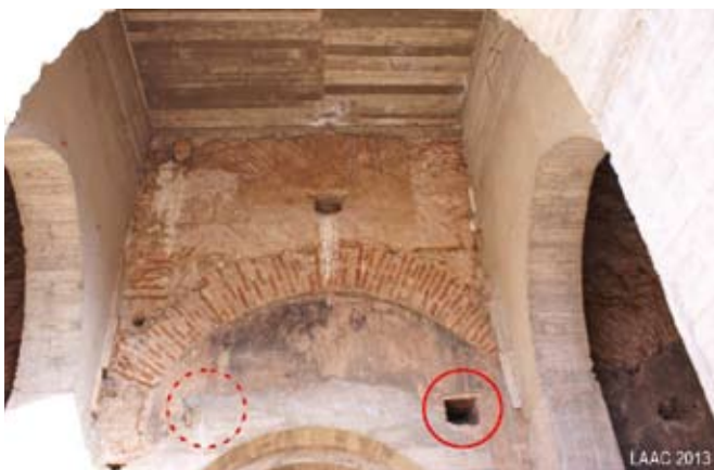
Fig. 23. Dar al-Hana. Edificio residencial. En la cara meridional del muro norte de la crujía de acceso se pueden observar los encastres para las gorroneeras de una gran puerta de hojas batientes
