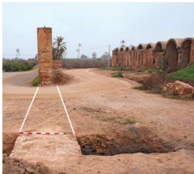
Fig. 8. Dar al-Hana. Muralla meridional, mitad oriental. Vista desde el oeste. La estructura inferior es más gruesa y pertenece probablemente al proyecto fundacional almohade. El alzado del fondo pertenecería a la reconstrucción saadí
