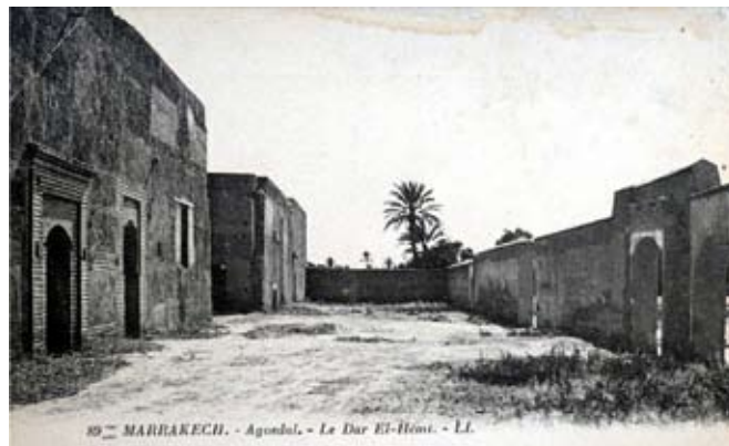
Fig. 11. Dar al-Hana. Edificio residencial. Tarjeta postal de principios del siglo XX que muestra una vista del patio que se extendía entre el cuerpo del edificio y la alberca. Se ve el estado en que se encontraban sus muros, que presentan pérdidas de la costra de la tapia, grietas y reparaciones. Todos los elementos visibles en la postal desaparecieron tras las obras de remodelación del edificio llevadas a cabo en la década de 1980
