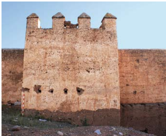
Fig. 20. Agdal. Muralla exterior. Frente occidental. Tramo anexo a la parcela Salha. La muralla y la torre actuales se asientan sobre los restos de otra preexistente, más oscura
