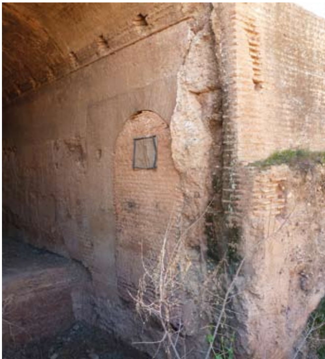
Fig. 28. Dar al-Hana. Caballerizas. Detalle del vano que lo comunicaba con el palacio saadí a través de un pasillo abovedado. Fue tapiado en época alauí. Véase su situación en la Fig. 27.C
