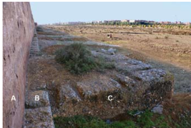
Fig. 21. Agdal. Muralla exterior. Frente occidental. Tramo anexo a la parcela de Salha. La actual muralla (A) se asienta sobre los restos de otra más antigua (B), cuya torre (C) no fue reconstruida
