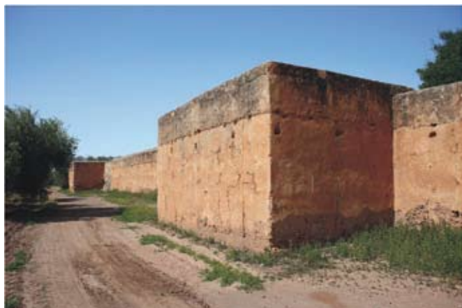
Fig. 14. Dar al-Hana. Vista del frente oriental de la muralla
