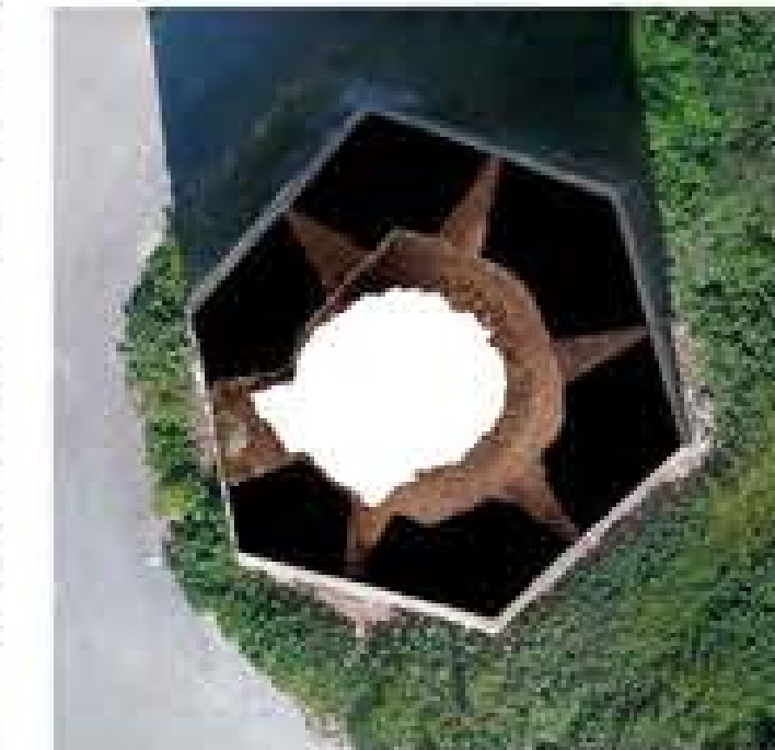
BÓVEDA DE LA ESTANCIA INFERIOR
