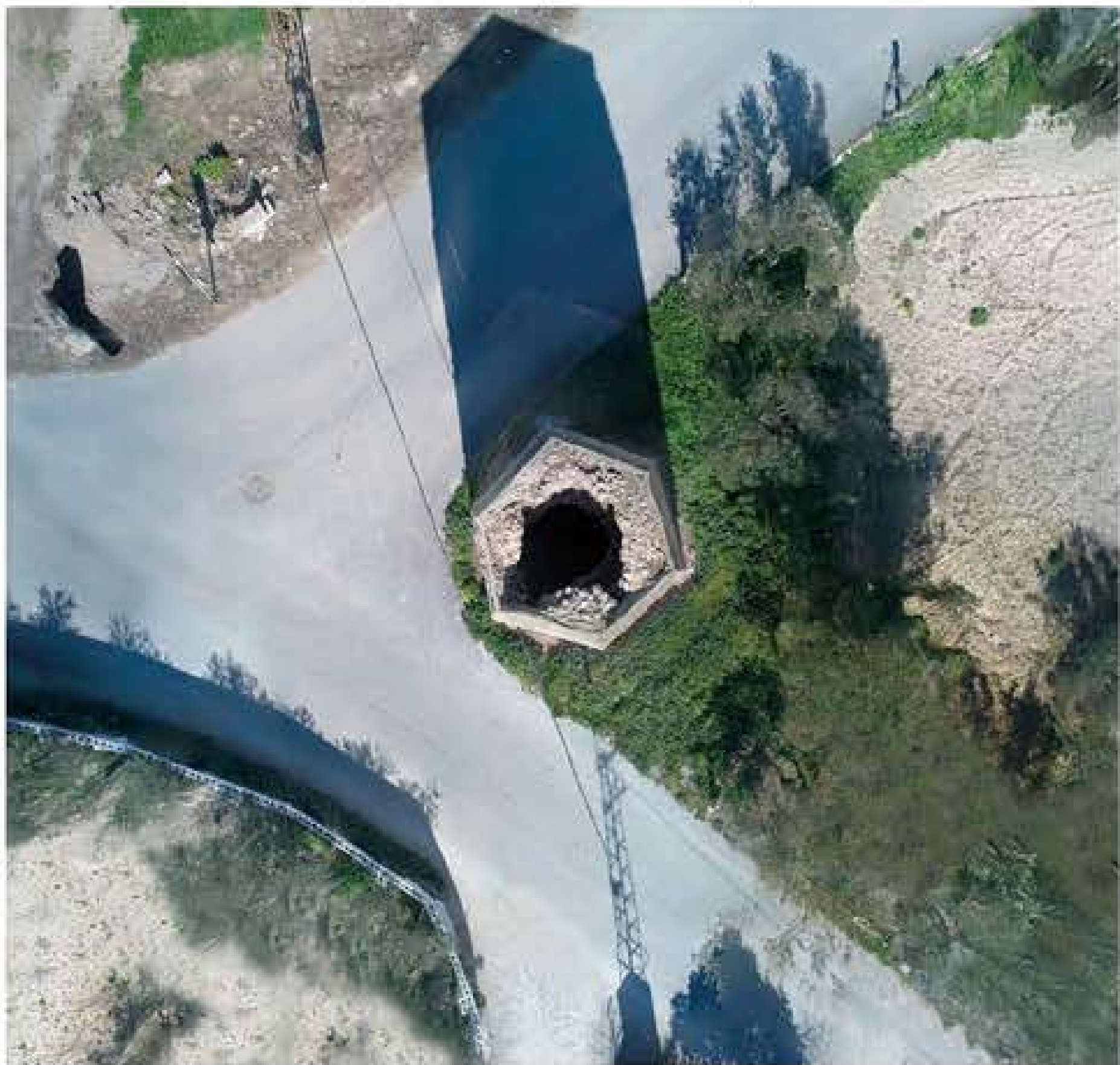
ORTOFOTOGRAFÍA EN PLANTA DEL ENTORNO DE LA TORRE
