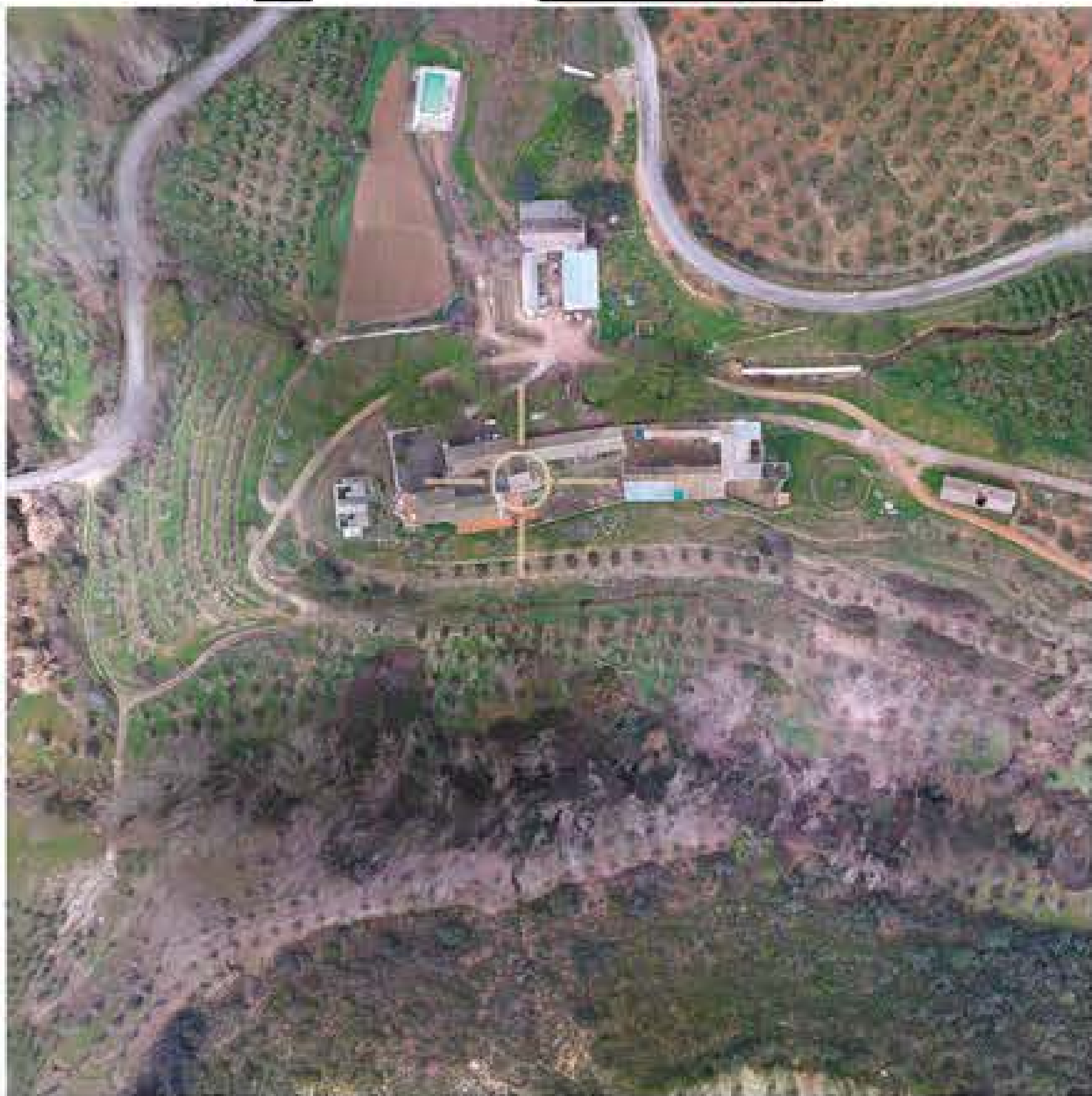
ORTOFOTOGRAFÍA EN PLANTA DEL ENTORNO DE LA TORRE
