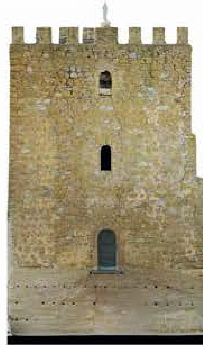
Torre del Cerro de la Ermita (Cúllar) alzado Norte
