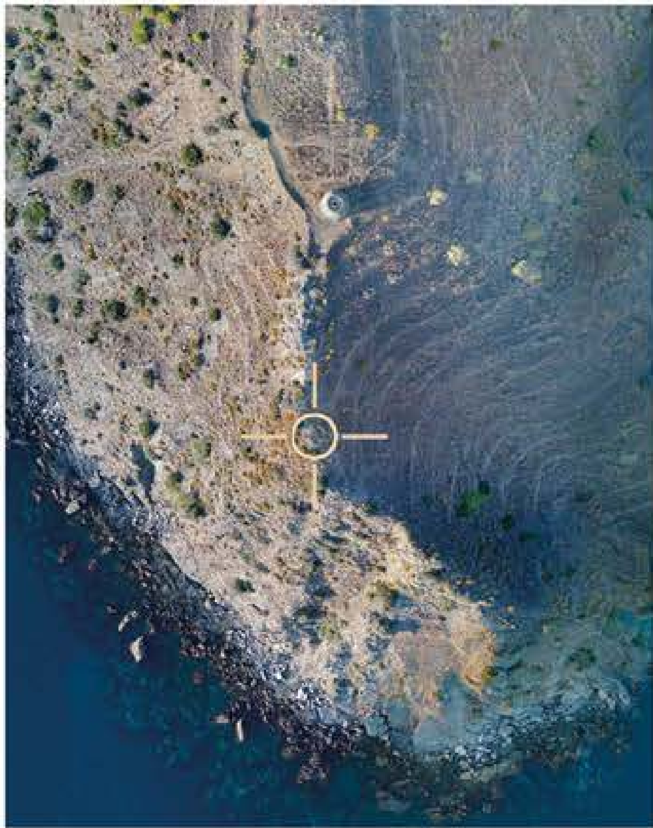
ORTOFOTOGRAFÍA EN PLANTA DEL ENTORNO DE LA TORRE
