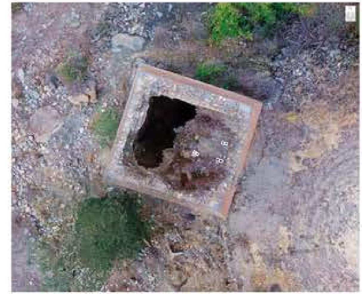
ORTOFOTOGRAFÍA DE LA PLANTA DE CUBIERTA ORIENTADA AL NORTE
