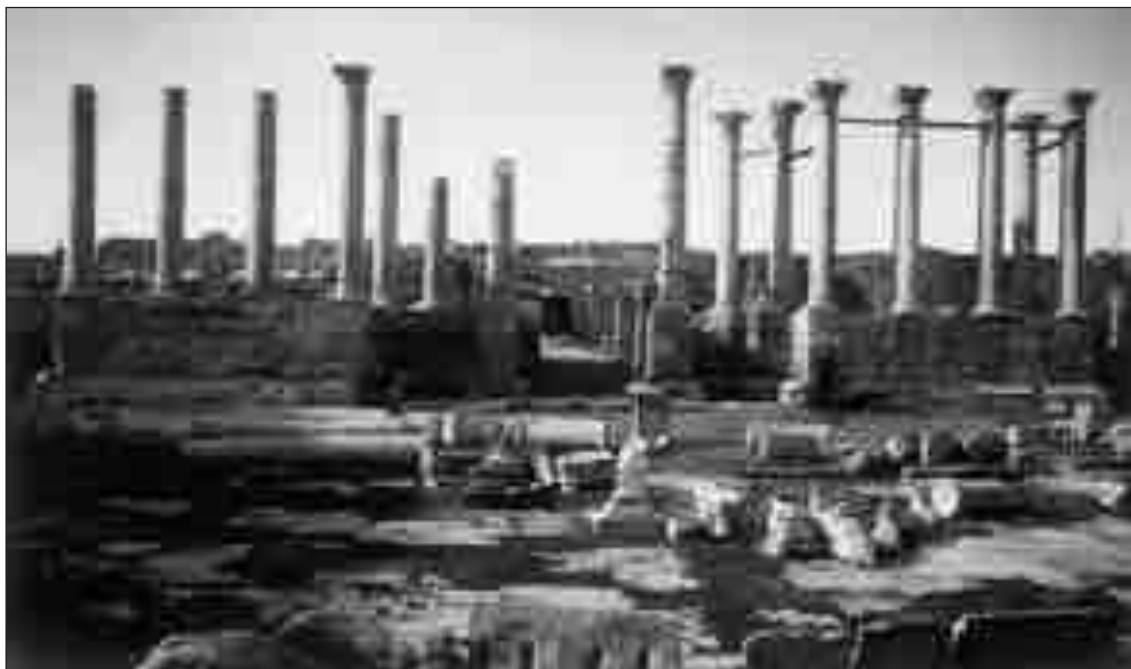
Figura 14. Aspecto del frente escénico al final de los trabajos de la primera fase, en 1922. Pueden observarse los tirantes que se sitúan entre las columnas para dar mayor solidez a la reconstitución, así como los aros en los fustes que sirven para sujetar entre sí los distintos fragmentos (Archivo Gómez-Millán Vela).
