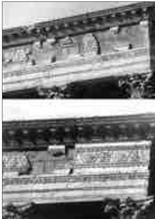
Figura 35. Comparación del entablamento del primer orden. Arriba: el realizado en los años veinte por Gómez Millán. Abajo: el entablamento recompuesto por Menéndez Pidal. La disposición es idéntica.
