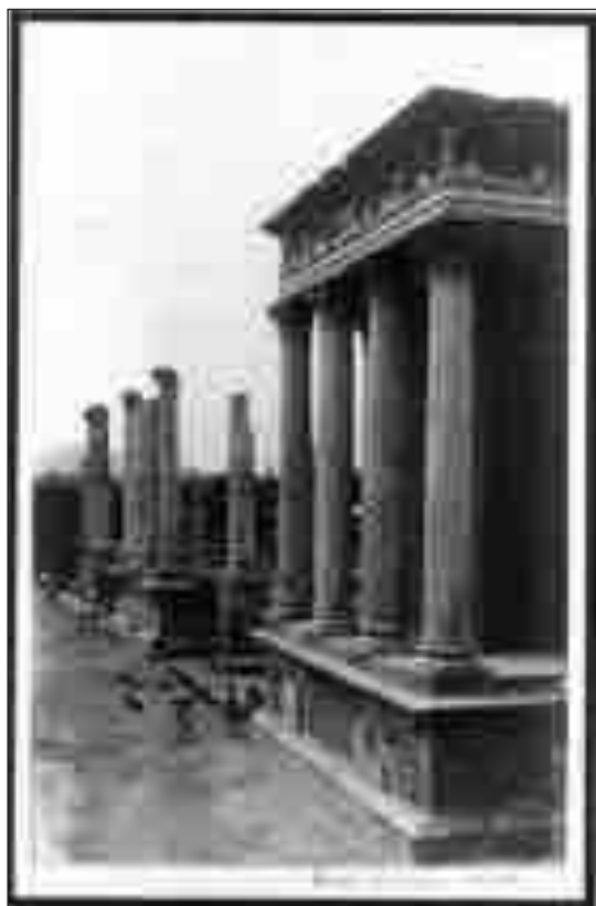
Figura 19. Detalle de la reconstitución de la escena al final de los trabajos en 1925. Pueden observarse los elementos reubicados en el podio y el entablamento (Barrero, Murciano y Velázquez 2014: 186-187).
