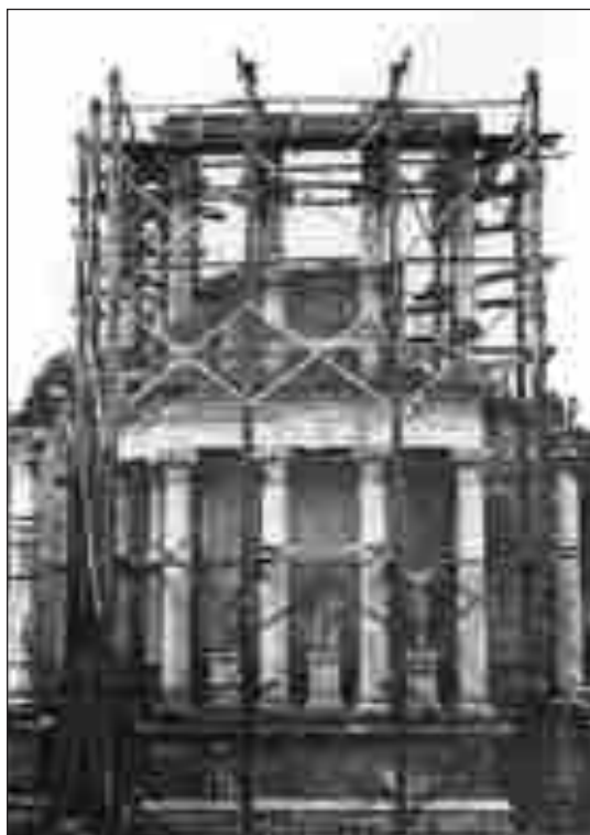
Figura 36. Andamios para el montaje del segundo cuerpo (Archivo del Museo Nacional de Arte Romano).
