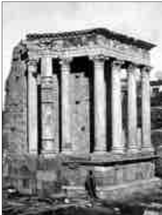
Figura 17. Detalle de la escena con el entablamento reconstituido a la derecha de la valva regia . Se puede observar que la moldura del podio se mantiene en la posición planteada inicialmente por A. Gómez Millán a sugerencia de Mérida (Archivo Gómez-Millán Vela).
