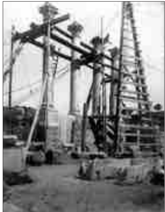
Figura 9. Las columnas del frente escénico en el primer momento del proceso de puesta en pie (Archivo Gómez-Millán Vela).
