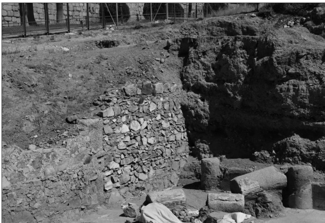
Fig. 4. Casa de la Huerta de Otero-Mérida (No. 3.), en fase de excavación en 2019. Muro tardío de aparejo mixto y material reciclado que provoca una transformación de la *domus* y amortiza la vía que recorre paralela a la muralla romana (Foto: Autores).
