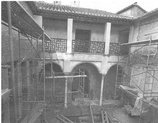
Arriba, lado norte del patio con la viga de descarga de la galería. Abajo, lado sur del patio durante la restauración.
