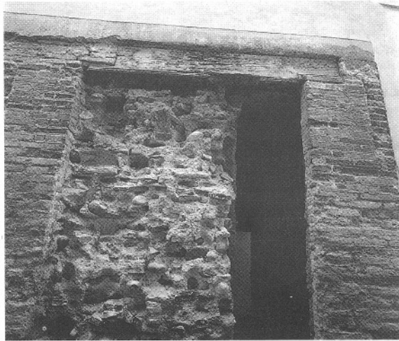
Arriba, crujía oriental sin los enlucidos. Abajo, la puerta mudéjar durante la restauración.
