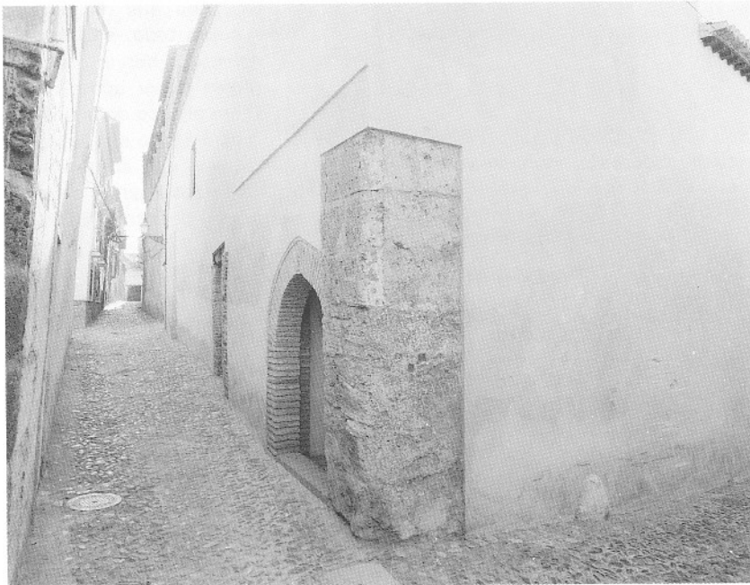
Puerta original de entrada a la casa después de la restauración
