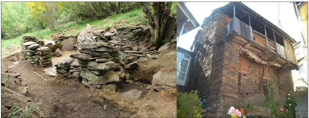
Figura 8. A la izquierda, la estructura Bruña-3; a la derecha, casa tradicional de Casaio con una disposición similar a la estructura guerrillera (Fotografía de los autores).
