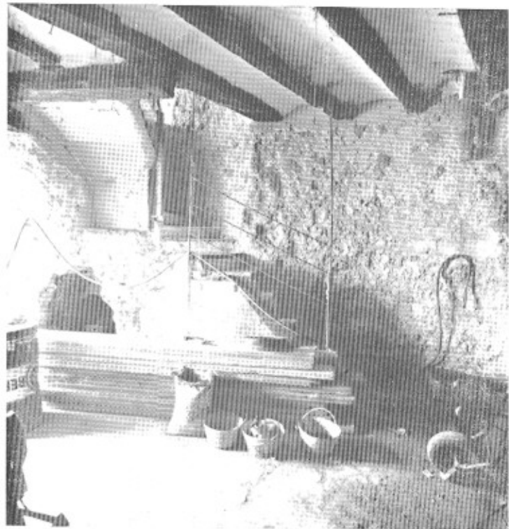
Lám. 7.—La planta baja antes de la restauración. A la derecha en la pared se aprecia la marca del arranque de la bóveda.
