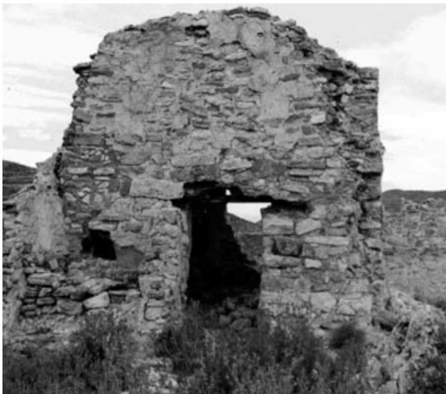
FIG. 3. Muro oeste de San Esteban de Canejada.
