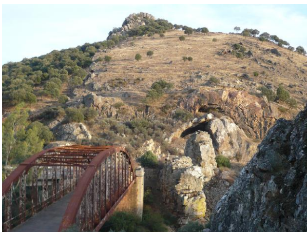
FIGURA 4. Vista del pequeño anticlinal de Aznarón, desarrollado en la Cuarcita Armoricana superior + Capas Pochico cerca del viejo puente de hierro sobre el río Valdeazogues, al sur de Almadén (N-502, km. 320). El contacto con los materiales preordovícicos (zona de bosque mediterráneo denso a la izquierda) es por falla, y la cuarcita ordovícica pasa lateralmente a un flanco normal buzante al suroeste.
