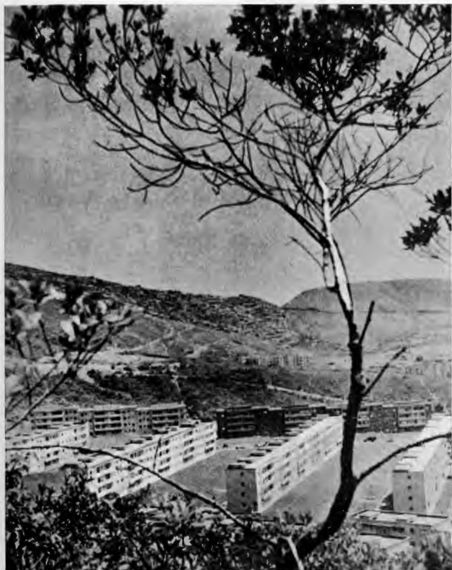
Unidad cooperativa de viviendas «Francisco de Miranda» (Caracas) Programa de edificaciones del Banco Obrero de Venezuela.
