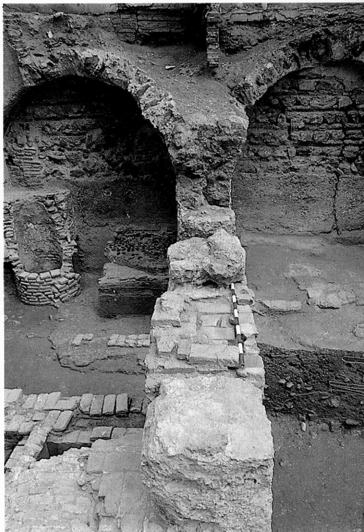
Baños de San Antonio (Murcia). Siglos XI-XII. Vista de las únicas dos salas conservadas. Al fondo se pueden apreciar los restos de las bóvedas. Abajo, el atajo oriental de la sala caliente («al-bayt al-sajūn»). A la derecha, la puerta por donde se accedía a la cabina donde estaba la pileta para el baño.
