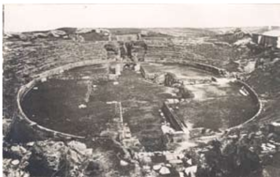
Fig. 5. Vista general del anfiteatro tras su excavación.
